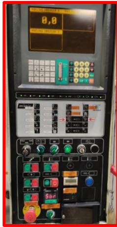
Figura 16 - Consola das insufladoras
