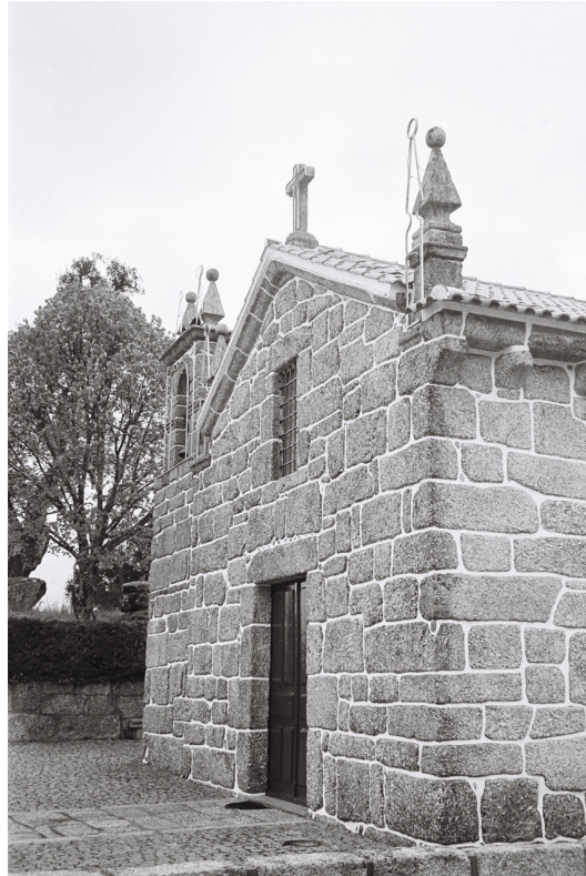
Figura 42: Repérage - Igreja de Vila Chã do Marão
