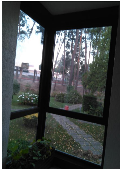
Figura 54 – Vão envidraçado – VE2_40S e VE2_41O
