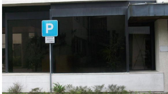
Figura 48 – Vão envidraçado – VE1_3N, VE1_4N e VE1_5N
