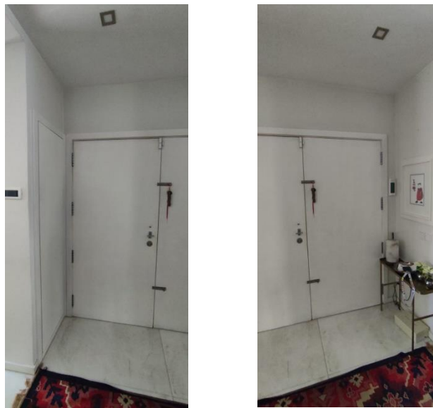
Figura 72 - Fotografias da porta de entrada existente
