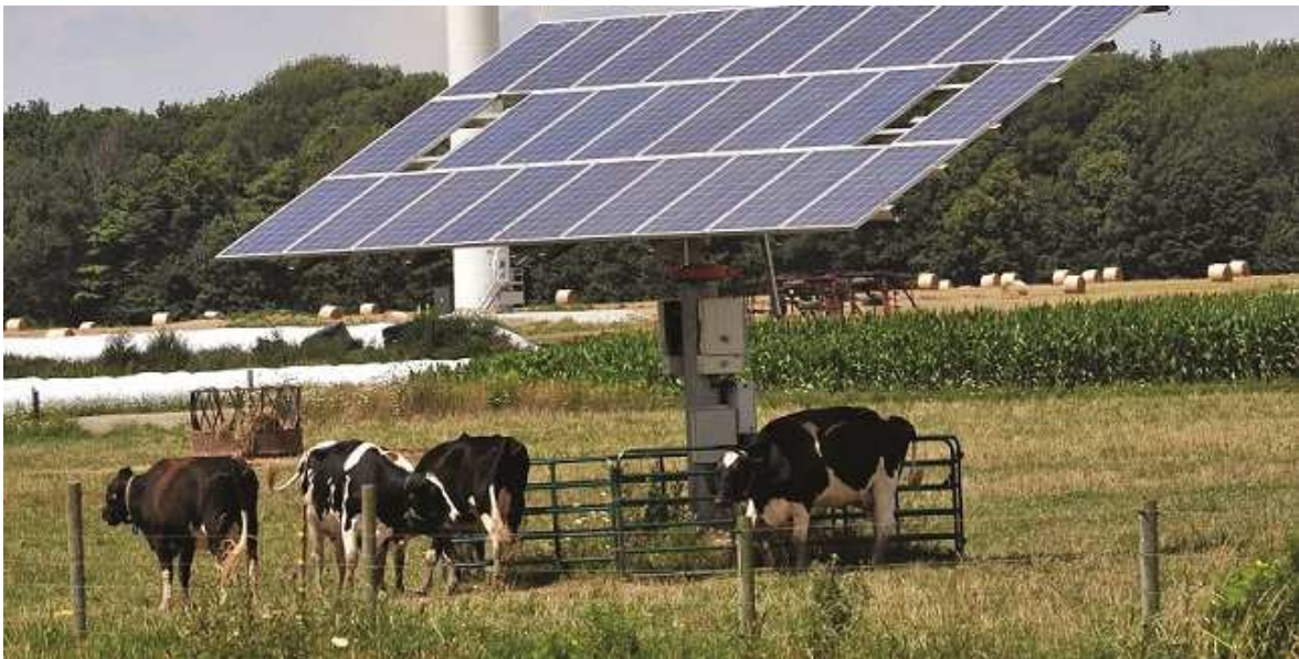
Figura 3: Sistema fotovoltaico aplicado à agricultura [17].
