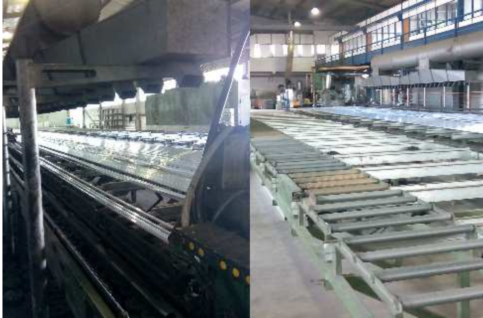
Figura 26: do lado esquerdo linha de ventiladores, para arrefecimento forçado, do lado direito, mesa de arrefecimento.
