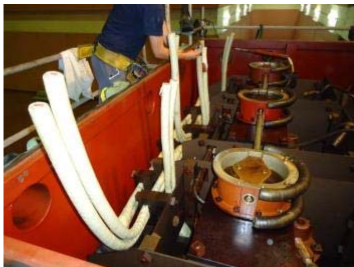
Vista geral antes da cravação dos terminais de ligação às travessias
