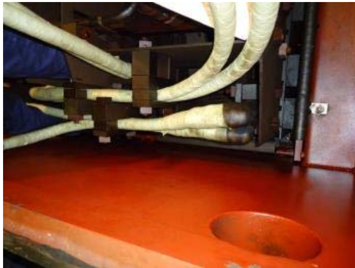
Retoma do aperto de montantes e limpeza
