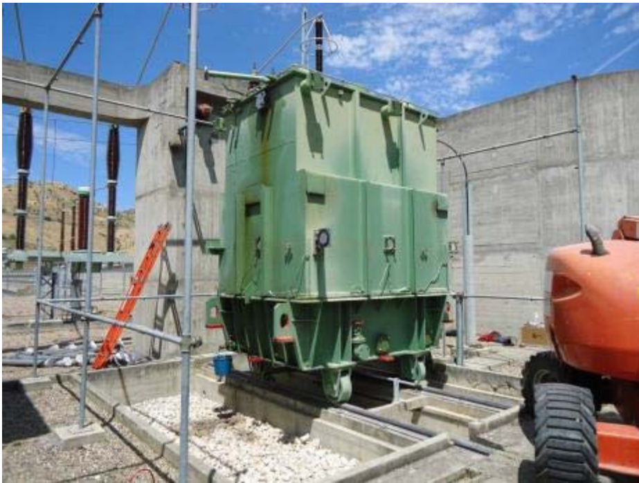
Transformador na cela com os acessórios desmontados e pronto a transportar para o túnel de acesso à sala de máquinas da Central
