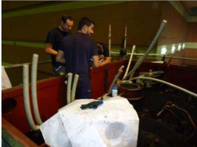
Vista geral dos cabos já emendados
