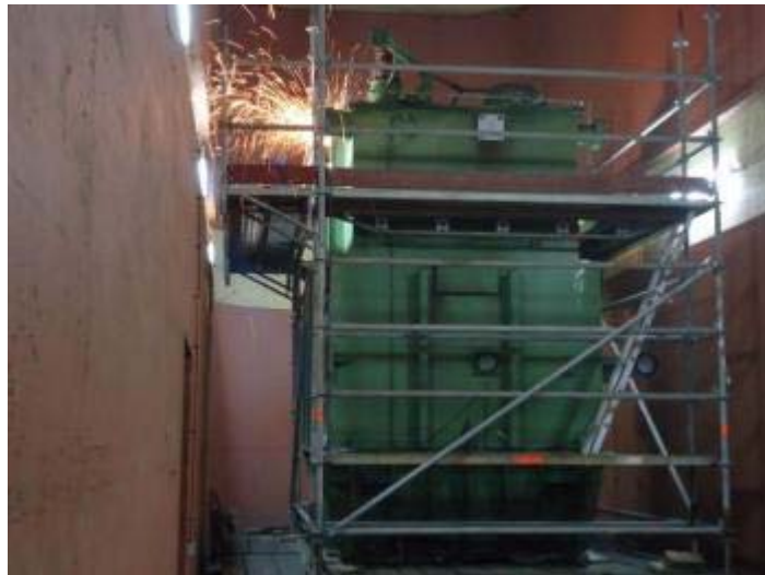
Operação de corte da tampa, no túnel de acesso
