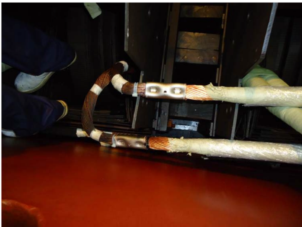
Figura 5.7 – Vista em pormenor da reparação efetuada nas conexões afetadas pelo defeito.
