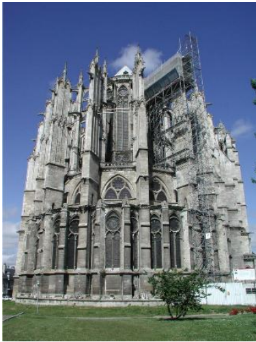
Figura 2.13: Vista exterior da Catedral de Beauvais.
