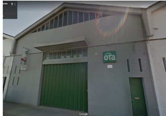
Figura 11 - Vista de frente do edifício.
