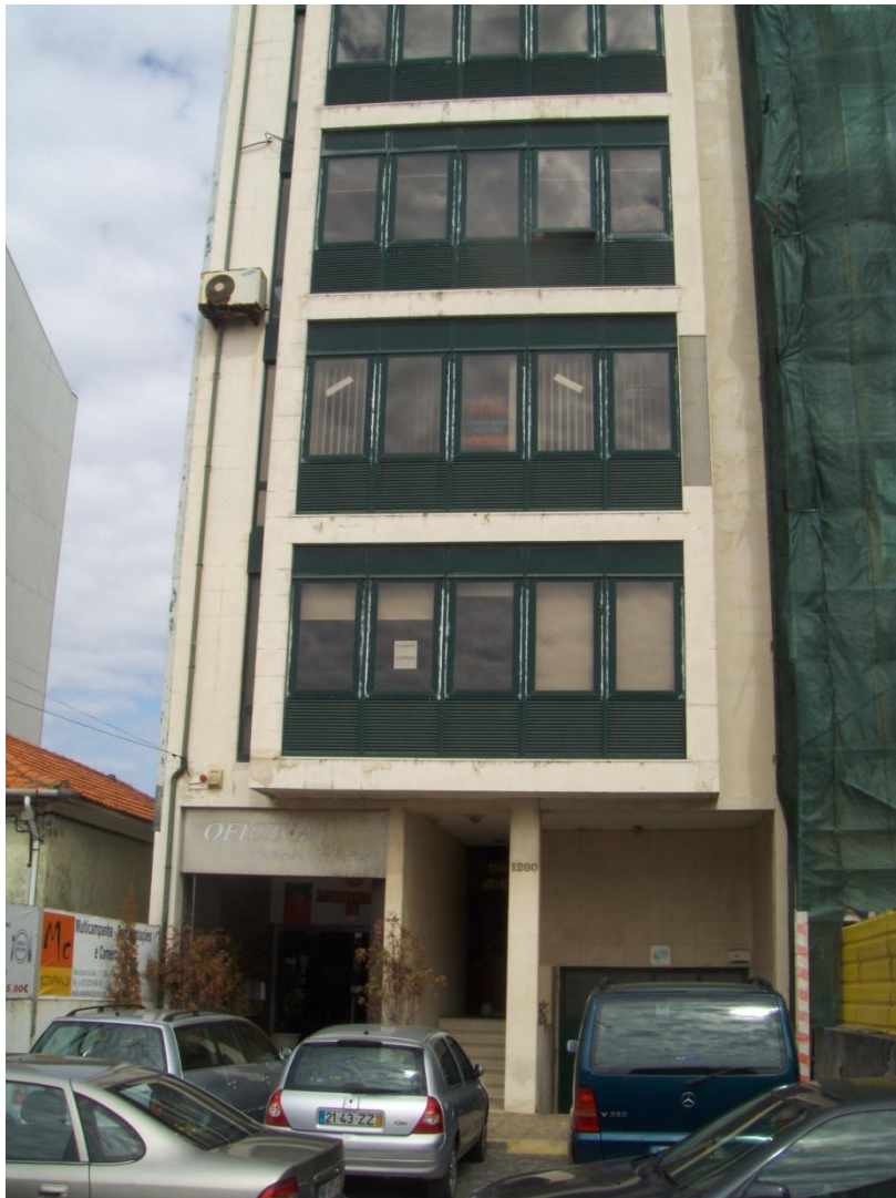
2 - Instalações da SmallPower .
