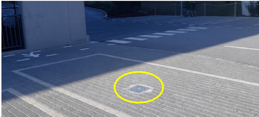
Figura 44 - Fotografia capturada pela autora da localização do INA ao PK 0+173, no edifício Mercadona
