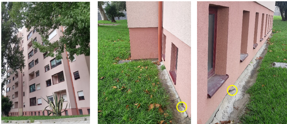
Figura 50 - Fotografias capturadas pela autora do edifício X32 na zona envolvente do Ramal-1, com os pinos de nivelamento incrustados na fachada
