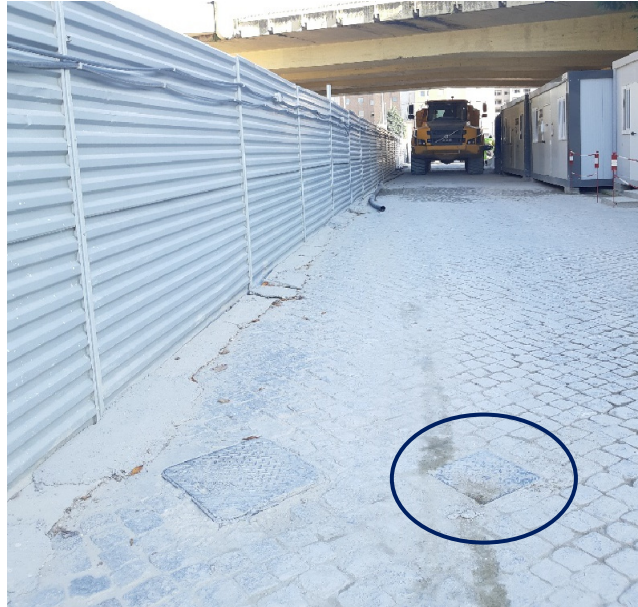
Figura 59 - Fotografia capturada pela autora da localização da Marca de Superfície ao PK 0+327
