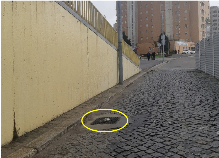
Figura 46 - Fotografia capturada pela autora da localização do extensómetro no PK 0+286, na Rua General Norton de Matos
