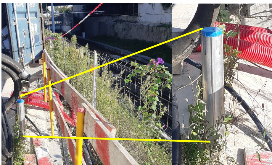
Figura 43 - Fotografia capturada pela autora da localização do Inclinómetro no PK 0+330, no maciço exterior à trincheira coberta, na vizinhança do emboquilhamento do túnel
