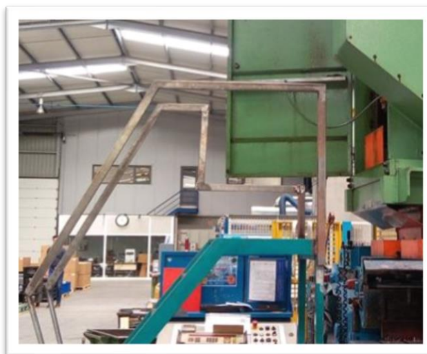
Figura 77 - Escada após modificação.
