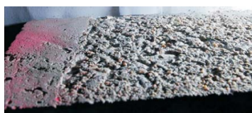
Figura 2.18: Betão C20/25 com 1300 bar de pressão
