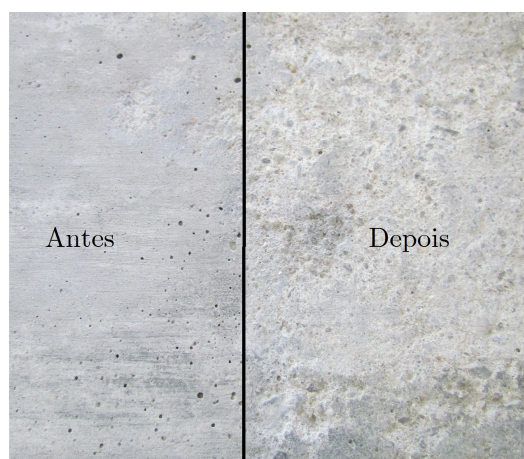
Figura 6.10: Superfície do betão antes e após preparação
