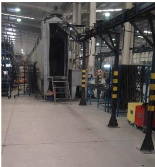
Figura 53 – Entrada do Túnel de Tratamento de Superfícies
