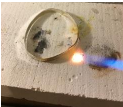
Figura 118: Soldagem do beirado
