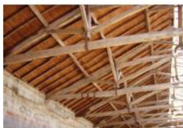
Fig. 36 – Ondutherm sobre estrutura existente
