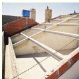
Fig. 39 – Aplicação de painel sobre estrutura de betão
