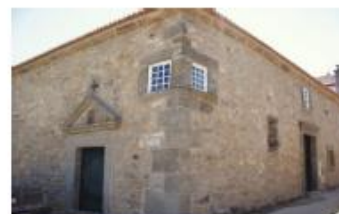
Aspecto final da argamassa
