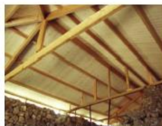
Fig. 37 – Ondutherm sobre estrutura nova
