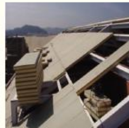
Fig. 40 – Aplicação de painel sobre estrutura metálica
