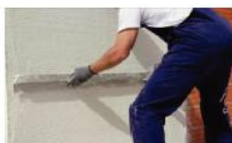
Regularização com régua metálica
