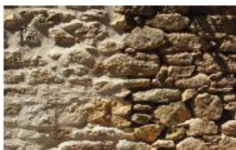
Aplicação manual da argamassa
