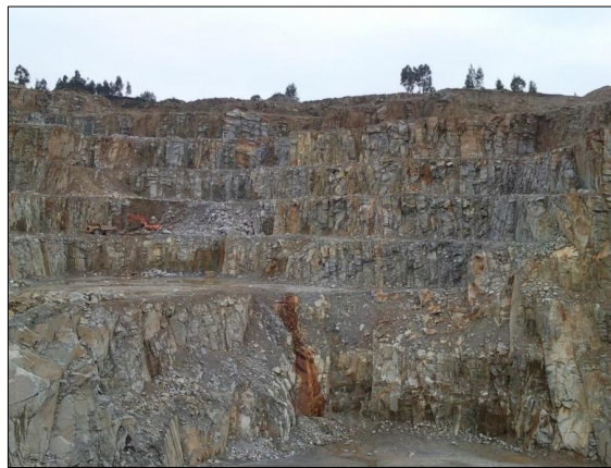
Figura 7 - Desmonte em flanco de encosta
