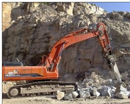
Figura 16 - Fragmentação secundária através do martelo hidráulico
