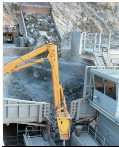
Figura 24 - Controle da alimentação de um fragmentador primário (Sampaio, 2006)
