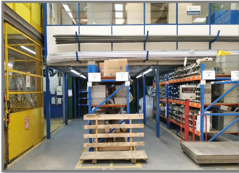
Figura 47 Posicionamento dos pilares da ferramentaria no acesso ao edifício B
