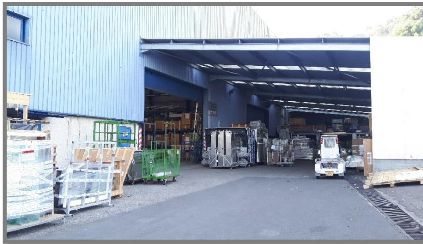
Figura 10 Zona de descarga
