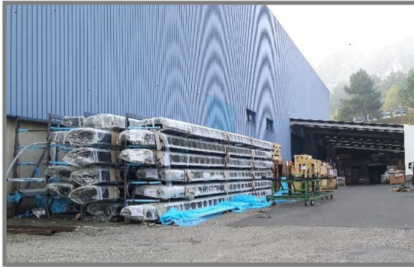
Figura 29 Conduatas no exterior (zona de descarga)
