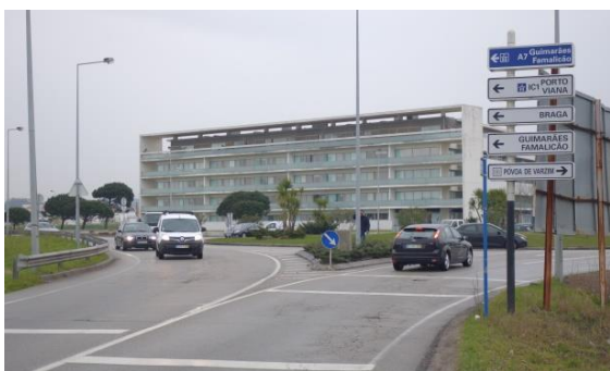
a) Ligação da Rua Engenheiro Ezequiel Campos à rotunda 4.
