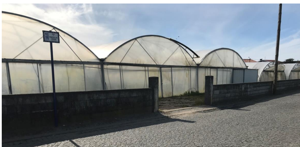
Figura 4.4 – Estufas a demolir na Rua do Parque da Cidade.
