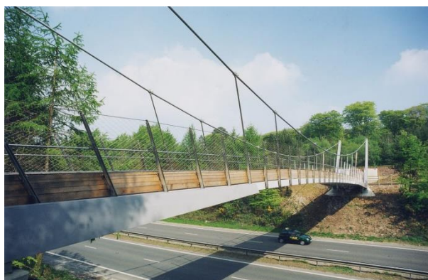
Figura 31 - Ponte construída com elementos compósitos curvos [106].
