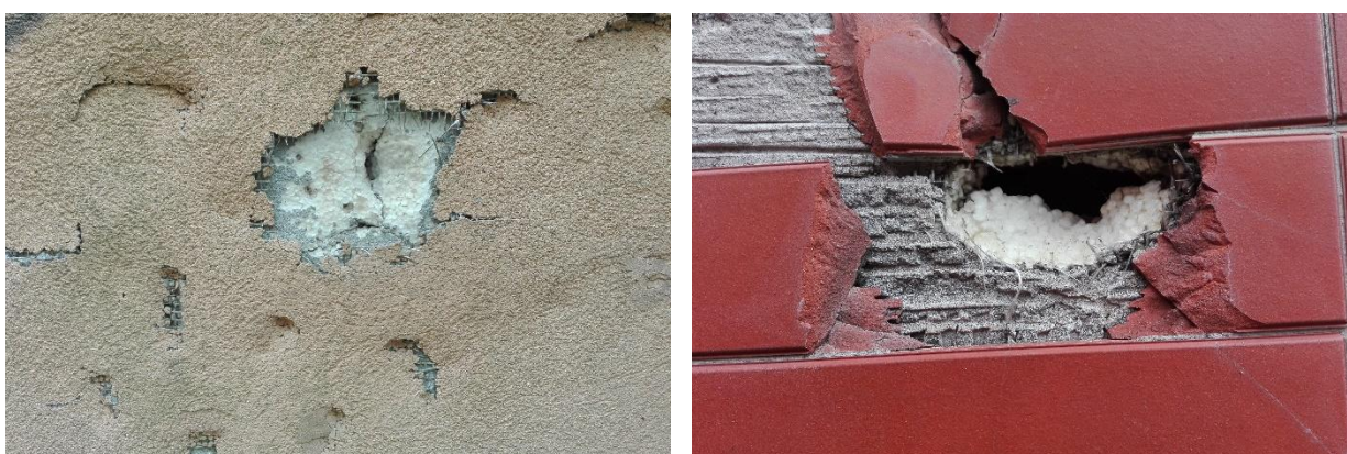
Figura 5.19 - Perfuração dos revestimentos exteriores
