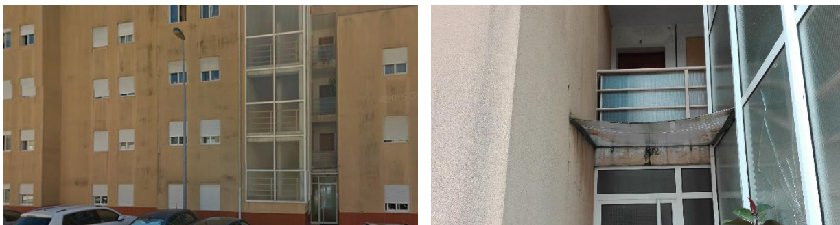
Figura 5.11 - Caixa de escadas e zona de circulação comum horizontal
