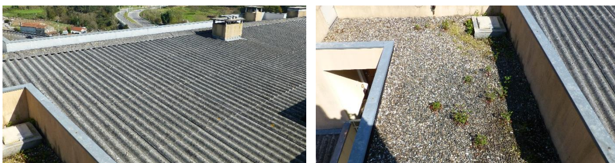
Figura 5.5 - Revestimento das coberturas
