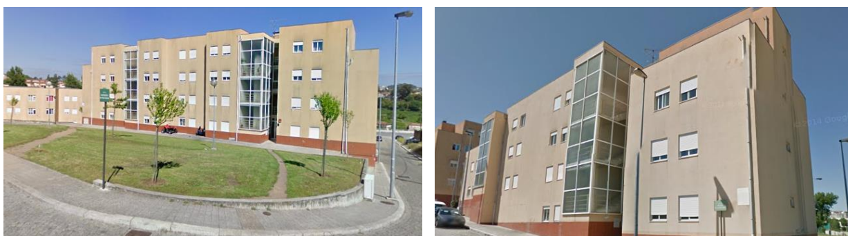
Figura 5.2 - Vista dos blocos A1 e C
