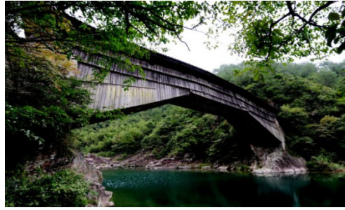
Figura 3.3 – Ponte em madeira com mais de 1000 anos, China (Greensavers, 2013)
