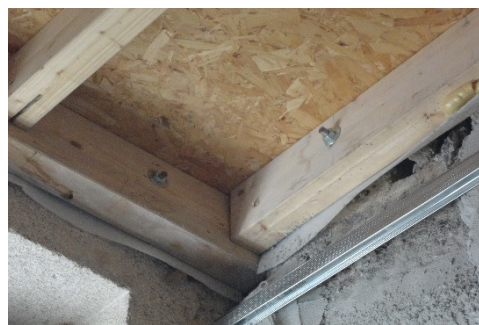
b) Foto em obra (vista inferior)
