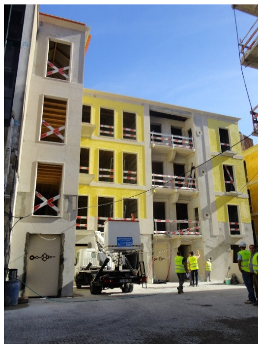
b) Fachada posterior (Praça das Cardosas)
