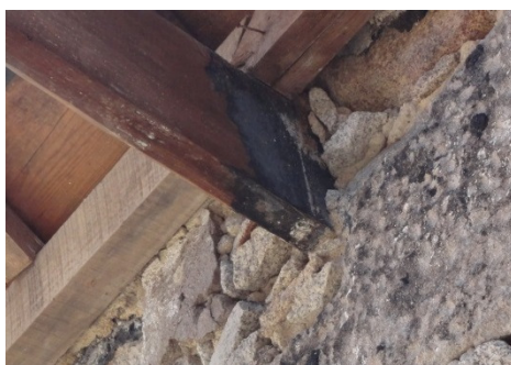
Figura 3.11 - Entregas de vigas com tratamento através de alcatrão
