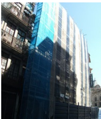
a) Contenção da fachada principal
