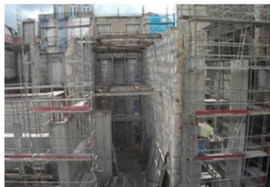
b) Demolições no interior dos edifícios
