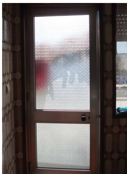
Figura 19 - Porta Envidraçada da Cozinha
