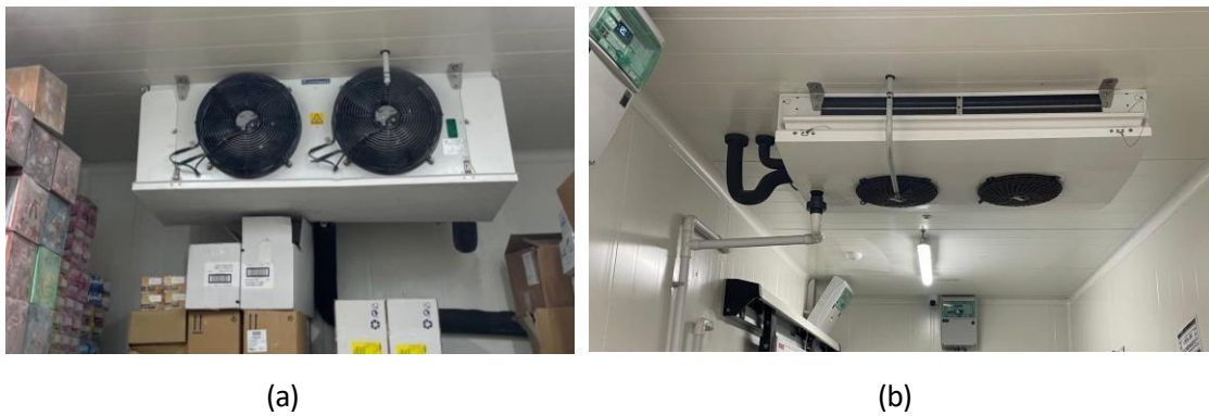
Figura 38- (a) Evaporador da câmara de congelados; (b) Evaporador de um corredor climatizado
