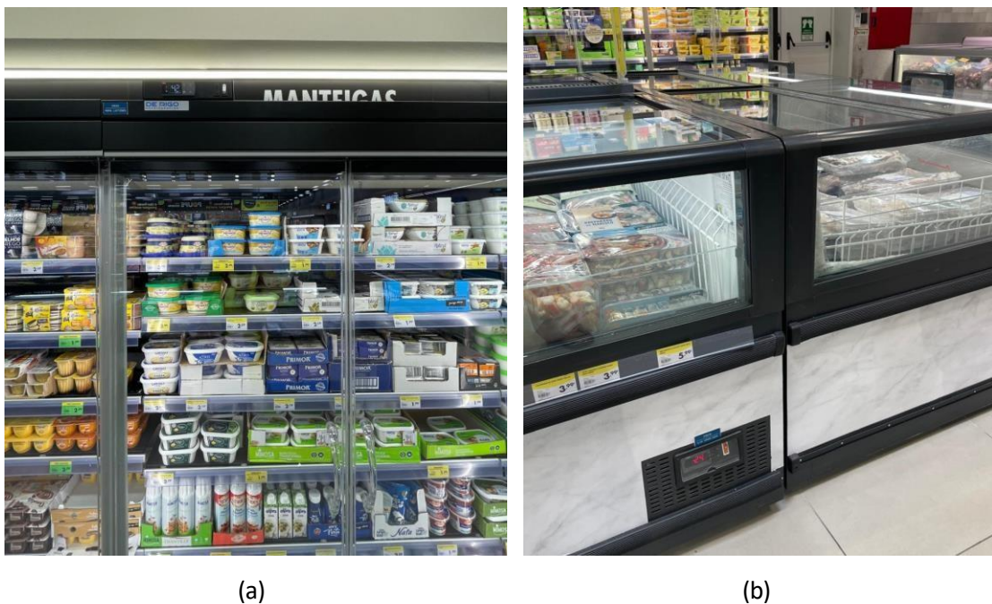
Figura 32-(a) Expositor em mural de refrigerados remoto; (b) Expositor numa arca de congelados autónomo
