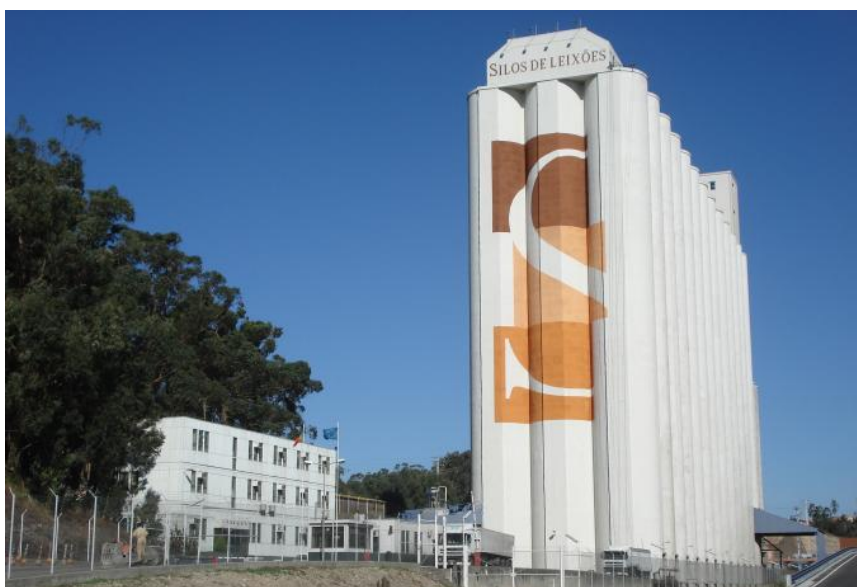
Figura 17 - Silos de Leixões, em Leça da Palmeira
