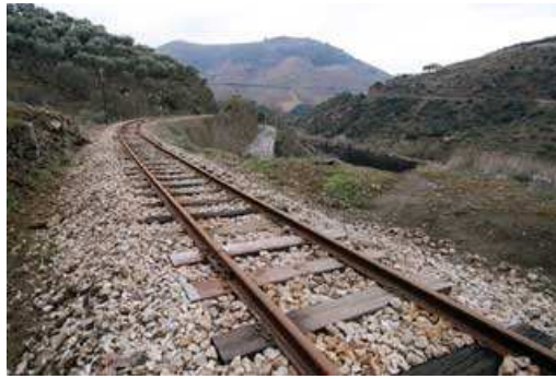
Imagem 39 – Linha ferroviária com travessas de madeira
