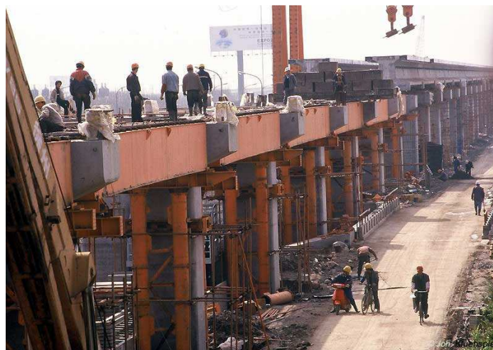
Imagem 48 – Construção da infraestrutura do Transrapid em Shanghai [37]
