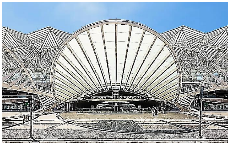
Figura 11 - Estrutura tubular da estação Gare do Oriente, em Lisboa [59].
