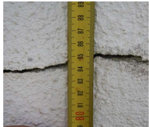
Fachada Sul A9
