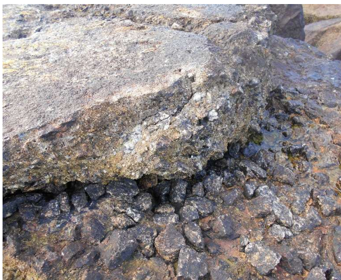
f) Pormenor de perda da pasta de cimento e seção do topo do molhe.
