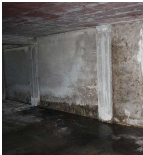
a) Parede da cave antes da intervenção.
