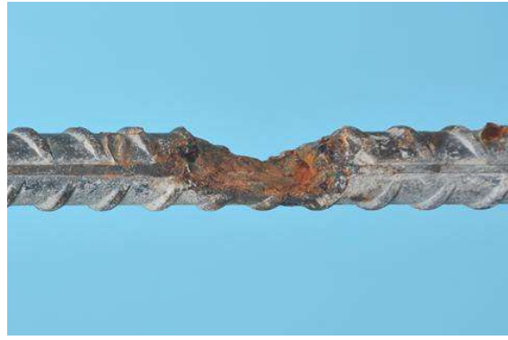
b) Pormenor de corrosão por picadas em varão de aço (www.duromac-cp.de).
