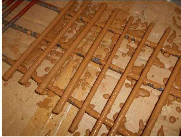
Figura 4.6 – Aplicação da argamassa de revestimento weber.rep 750 .
