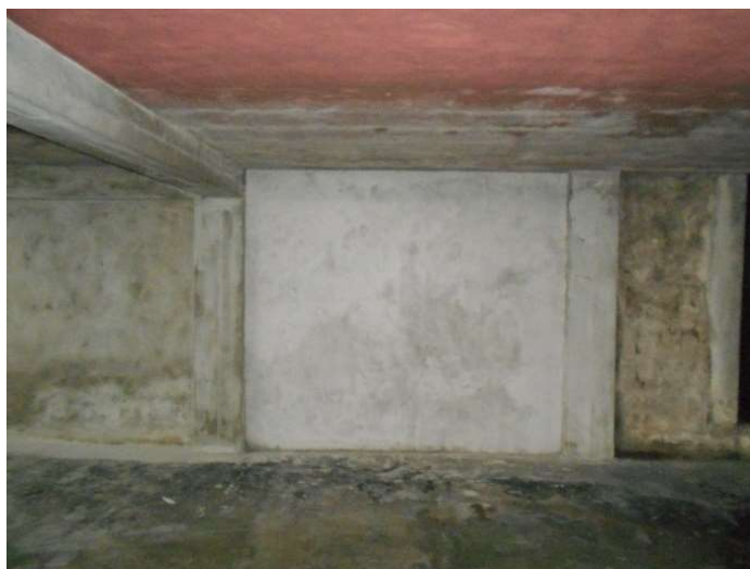
b) Parede da cave depois da intervenção.
