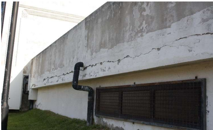
Fachada Sul A9
