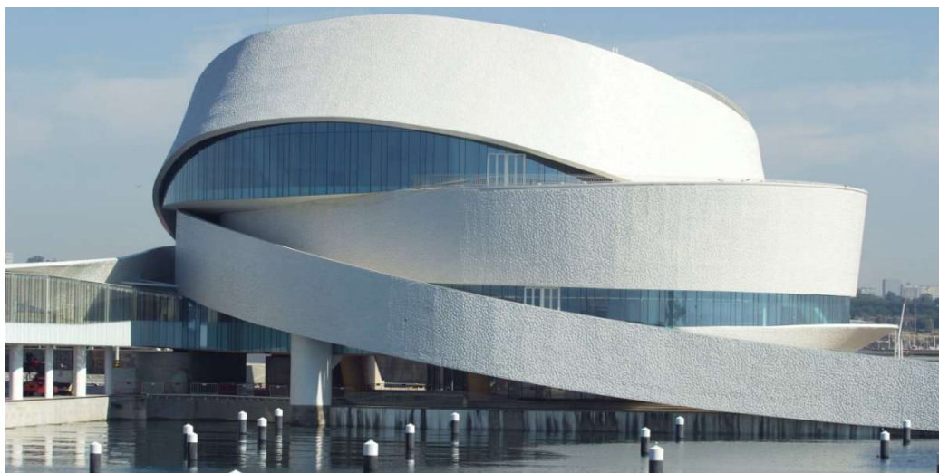
Figura 2.1 – Terminal de cruzeiros do Porto de Leixões ( www.casareport.pt ).
