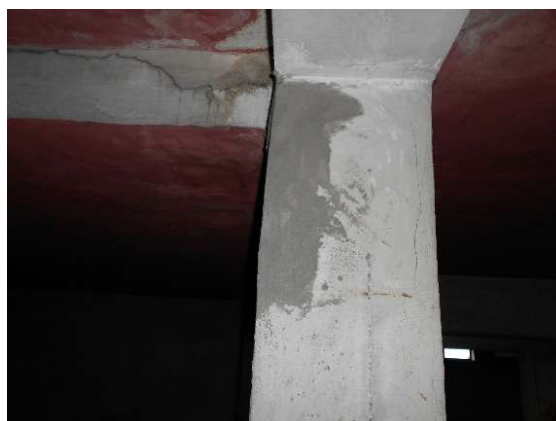
b) Pilar P11 depois da intervenção.
