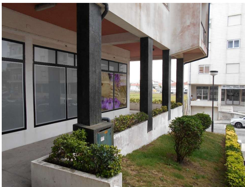
Figura 5.7 – Alçado Este: Registo fotográfico.
