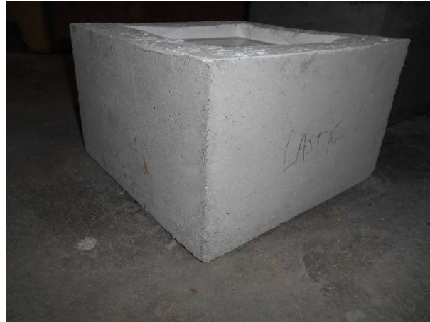
Figura 4.33 – Revestimento weber.dry lastic após finalização do ensaio: laterais.
