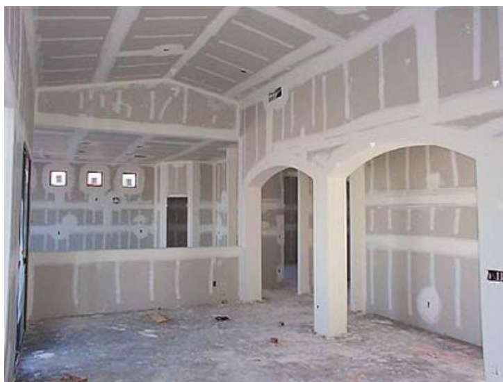
Figura 3 - Paredes internas de uma habitação, em gesso cartonado.
