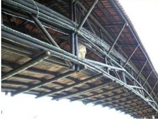
Figura 17 - Ponte em bambu na Colômbia
