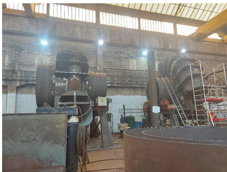
Figura 15 - Turbinas hidroelétricas Andritz (Áustria)
