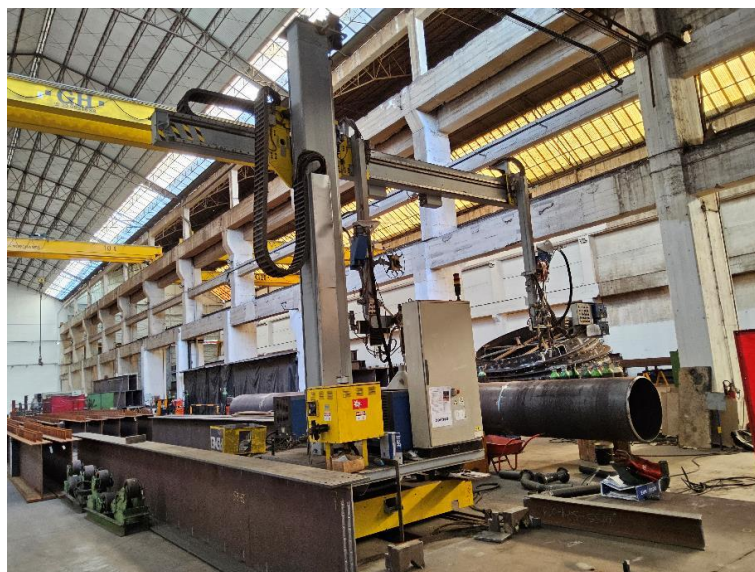
Figura 34 - Cristo de soldadura
