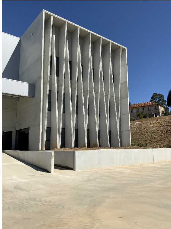
Figura 3.12 – Palas verticais da zona administrativa
