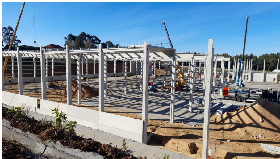
Figura 3.8 – Colocação dos painéis e das vigas
