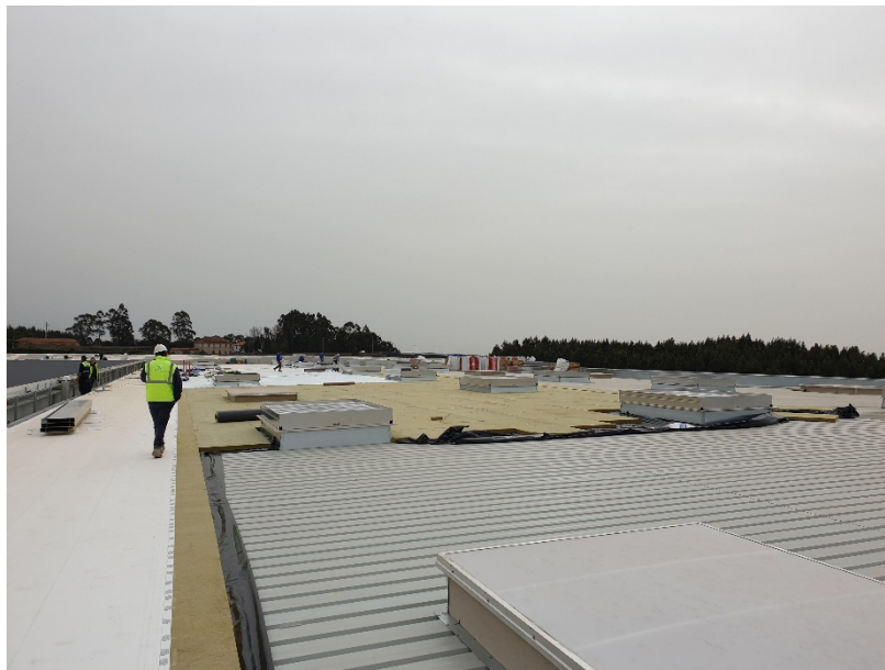
Figura 3.9 – Cobertura do edifício
