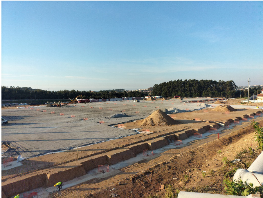
Figura 3.6 – Aplicação de manta geotêxtil e camada de tout-venant
