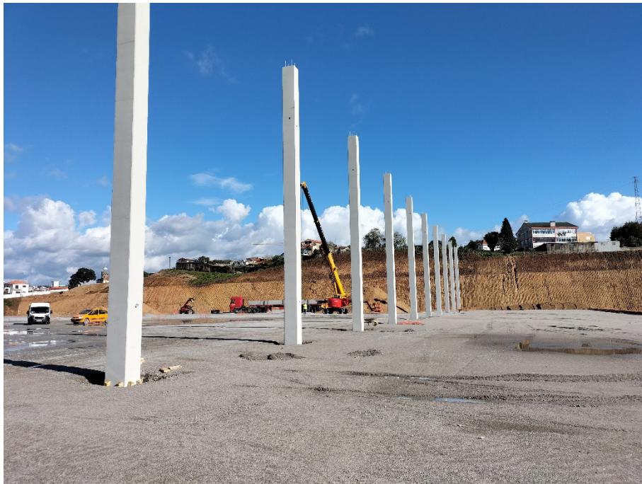
Figura 3.7 – Colocação dos pilares
