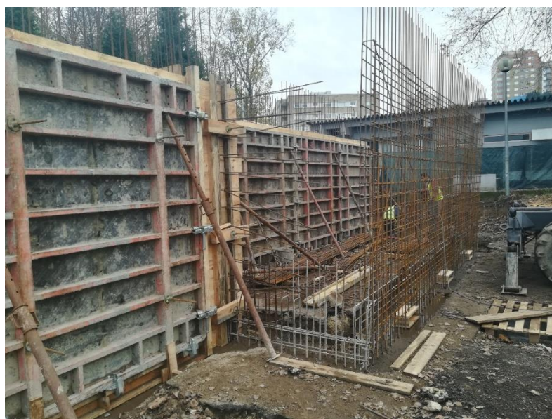
Figura 2.13 – Colocação de armaduras e cofragem em elementos verticais no Alpendre (bloco dos professores)
