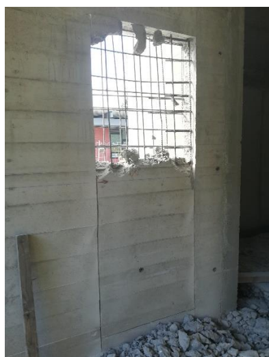
a) Fase inicial da realização de uma abertura num elemento estrutural
