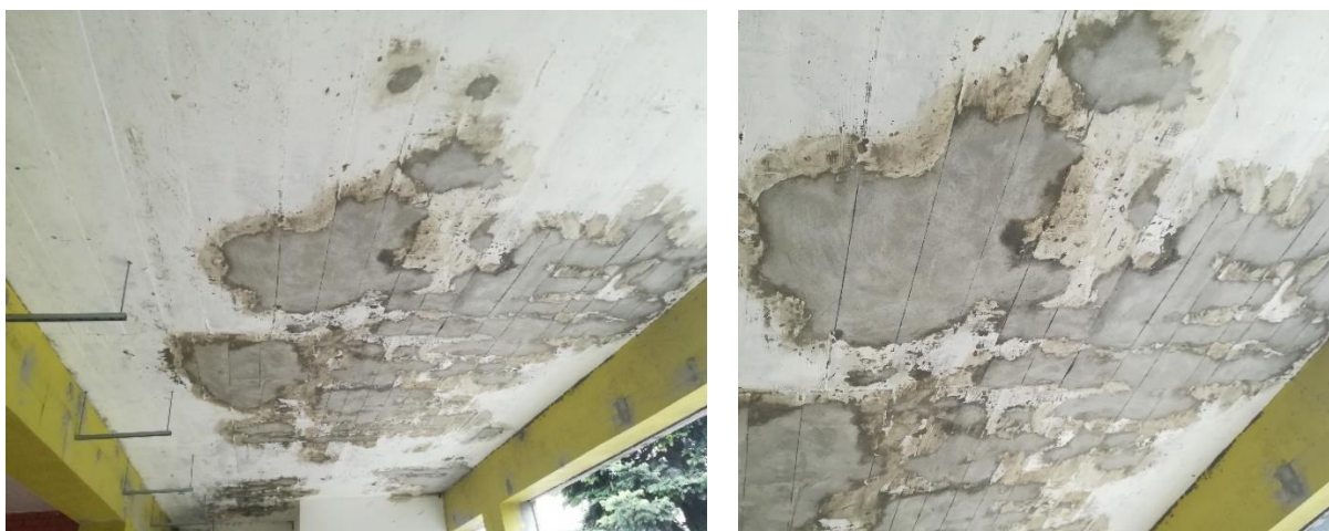
Figura 2.7 – Exemplo do estado (pós intervenção) de uma laje no bloco A4
