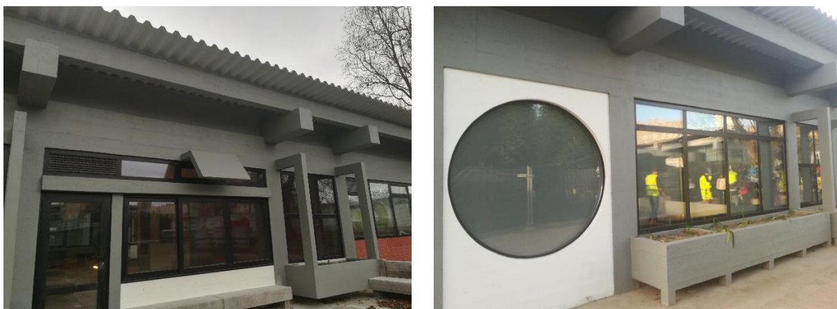
Figura 2.3 – Estado final de vertentes da fachada referentes ao bloco A4
