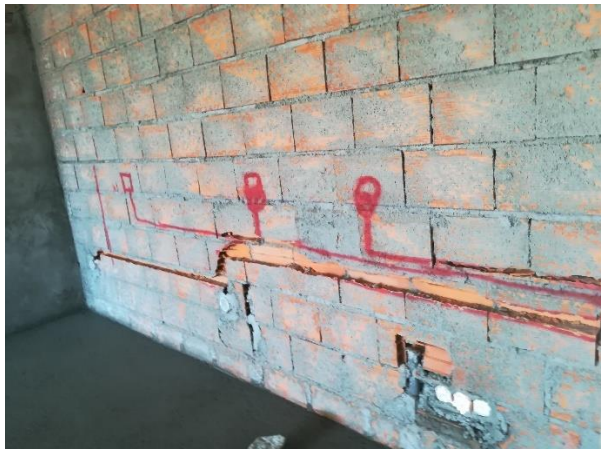
b) Colocação das infraestruturas
