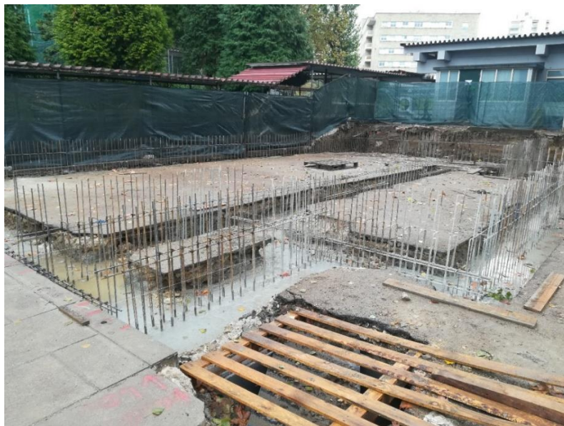
Figura 2.12 - Execução das fundações no Alpendre (bloco dos professores)
