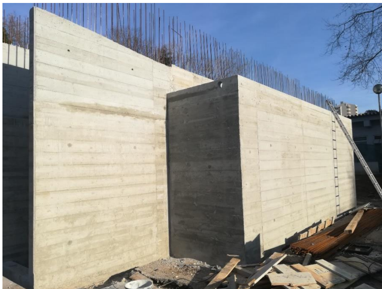
Figura 2.14 – Elementos verticais após descofragem do Alpendre (bloco dos professores)
