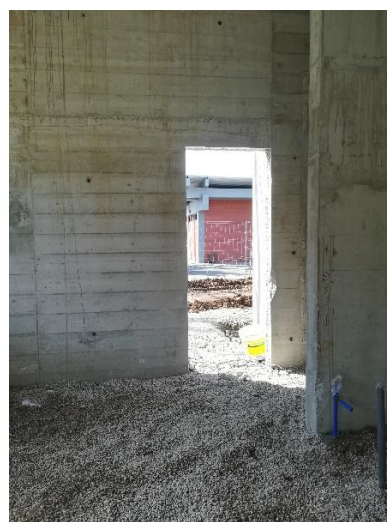
b) Fase final da realização de uma abertura num elemento estrutural
