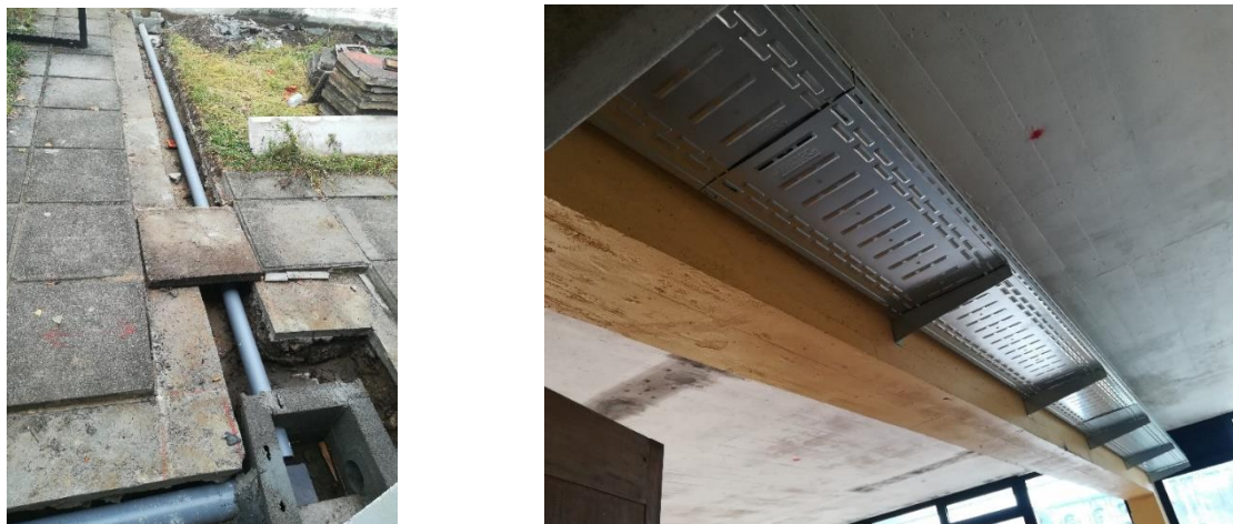
Figura 2.11 – Colocação de novas infraestruturas
