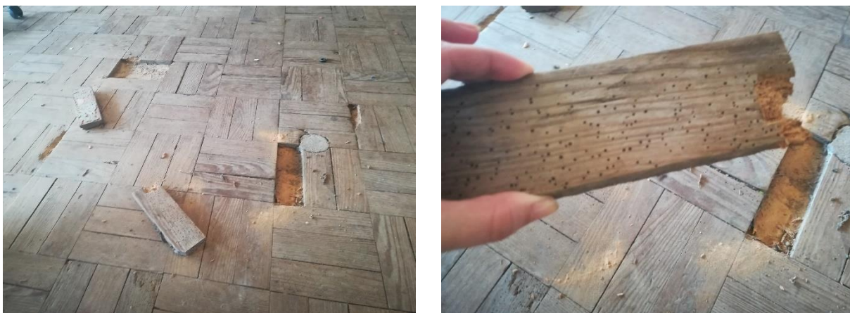
Figura 2.9 – Exemplo do estado inicial (sem intervenção) de um dos pavimentos no bloco A4
