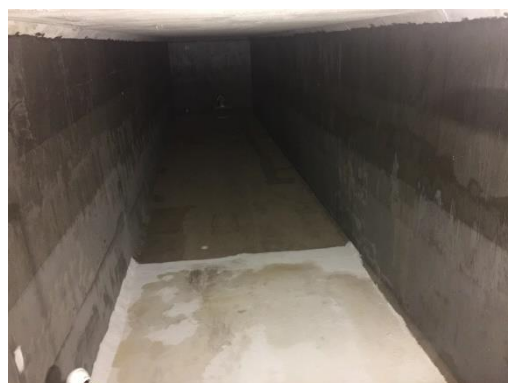
Figura 6.11 – Reparação de pavimento do Reservatório de incêndio “0-AL-30” [Data: 10.10.2017]
