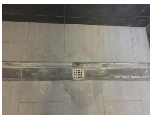
Figura 6.37 – Execução da caleira [Data:08.08.2017]
