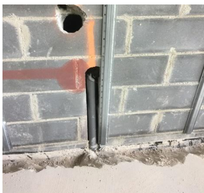
Figura 6.29 – Picagem do pavimento, zona dos roços [Data: 16.05.2017]
