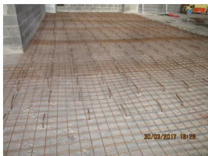
Figura 6.7 - Reforço da laje do Corpo A, aplicação de malhasol e ferrolhos. [Data: 30.03.2017]
