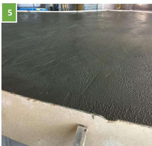
5 – Betonagem (área 2) – [Data: 16.05.2017]
