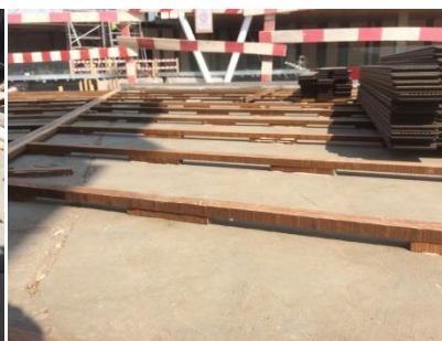
Figura 5.45 – Perfis de madeira e cunhas de apoio coladas [Data:17.08.2017]
