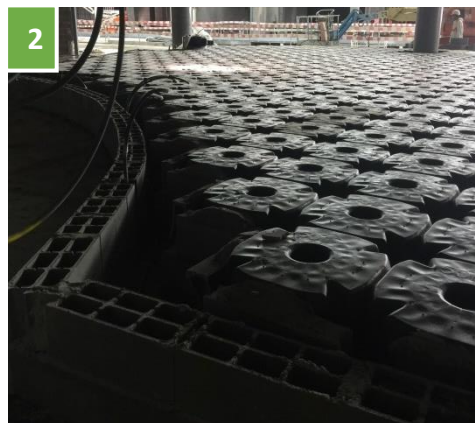
2 – Montagem dos módulos Cupolex 50 (Área 2) – [Data: 09.05.2017]
