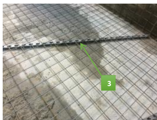
Figura 5.11 – Preparação da Malhasol e juntas para posterior colocação do pavimento Betão Afagado [Data:2017.02.08]
