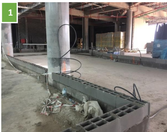
1 – Realização de murete para envolvente do Cupolex (Área 3) – [Data: 10.05.2017]
