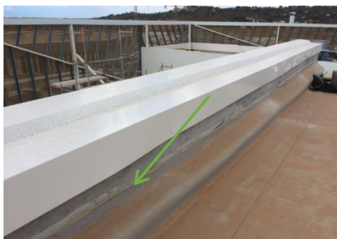
Figura 6.24 – Impermeabilização na platibanda com Rufo e tela PVC
