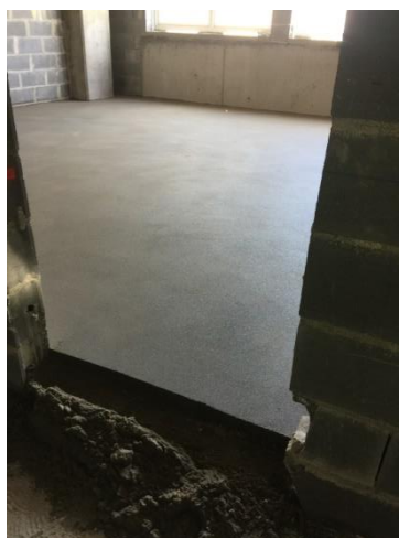
Figura 5.26 – Pavimento em betão leve com 18.5 cm + Recobrimento em betonilha 5 cm [Data: 03.05.2017]
