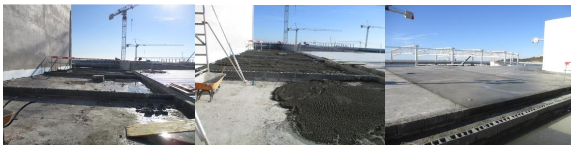
Figura 5.81 – Enchimento de Betão Leve e Betonilha, Cobertura do Corpo A [Data: 21.12.2016, Fonte:IPP]
