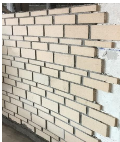
Figura 5.54 – Terracota após barramento das juntas com argamassa de cimento [Data: 12.07.2017]
