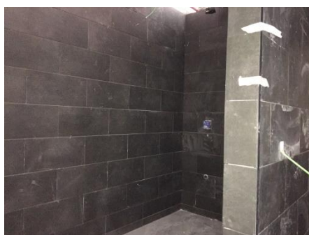
Figura 5.31 – Paredes de alvenaria revestidas a cerâmico concluído [Data: 20.07.2017]
