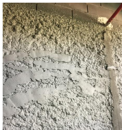
Figura 5.30 – Correção da parede de alvenaria com reboco projetado [Data: 04.07.2017]
