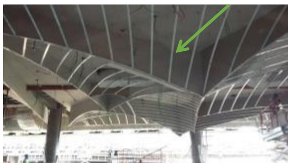
Figura 5.63 - Montagem do Teto Falso – Colocação dos perfis de alumínio [Data:13.06.2017]
