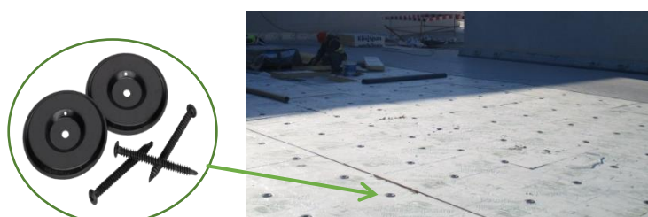
Figura 5.82 – Fixação do PIR com utilização de Plates RhinoBond
