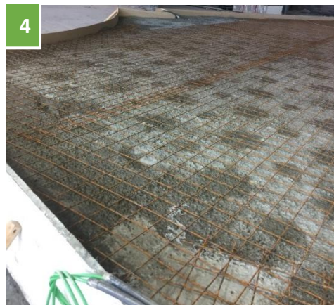
4 – Colocação da malhasol sobre os Módulos (Área 2) – [Data: 16.05.2017]
