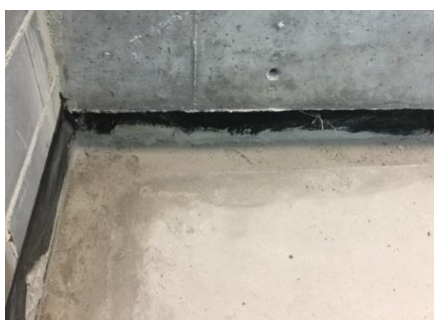
Figura 6.31 – Remate da Tela asfáltica executado [Data: 18.05.2017]
