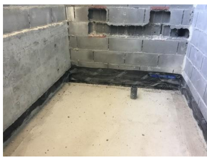
Figura 6.32 – Remate da tela asfáltica executado, zona dos chuveiros [Data: 18.05.2017]
