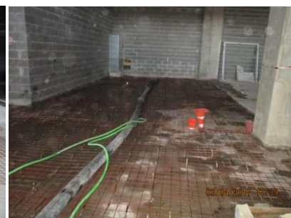
Figura 6.9 – Iniciação de betonagem [Data: 03.04.2017]
