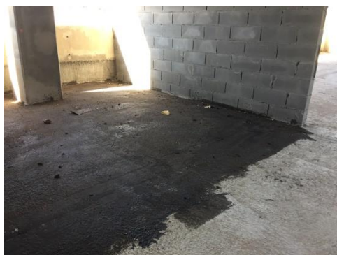
Figura 5.19 – Aplicação da emulsão betuminosa [Data: 06.04.2017]
