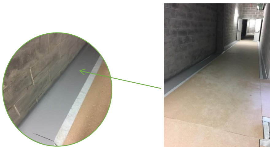
Figura 5.14 - Pavimento Epóxi concluído e protegido [Data: 12.07.2017]
