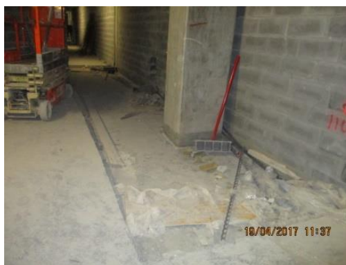
Figura 6.2 – Desfasamento entre lajes [Data: 19.04.2017]
