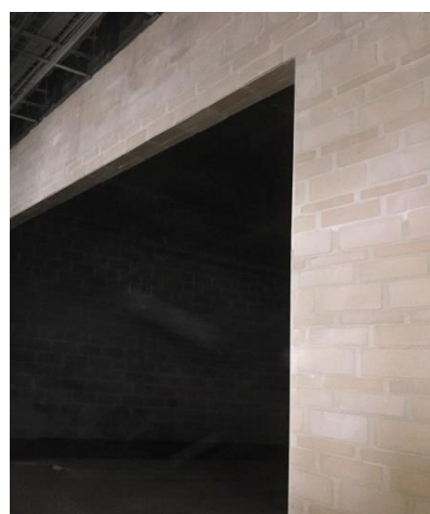
Figura 5.53 – Acabamento Final do Terracota após a aplicação de betume [Data: 08.08.2017]
