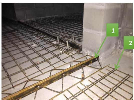
Figura 5.10 – Preparação da armadura para posterior colocação do pavimento Betão Afagado [Data:2017.02.08]
