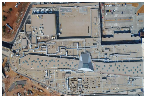
Figura 6.17 – Fotografia aérea da Cobertura do edifício em Julho de 2017
