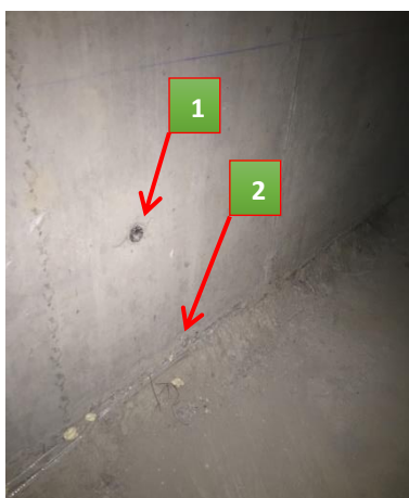
Figura 5.2 – Juntas de construção e tiges antes da realização da impermeabilização [Data: 16.05.2017]
