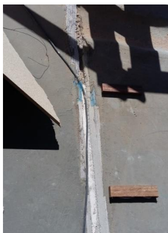
Figura 5.96 – Impermeabilização do pavimento [Data: 08.08.2017]
