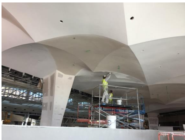
Figura 5.68 - Montagem Teto Falso – Barramento geral com BASWA acoustic® [Data:04.09.2017]
