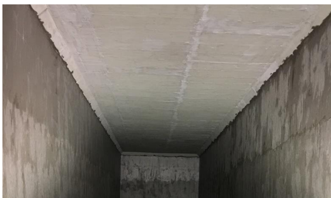
Figura 5.5 – Teto do Reservatório de Incêndio após aplicação do MasterSeal® 531 [Data:03.06.2017]
