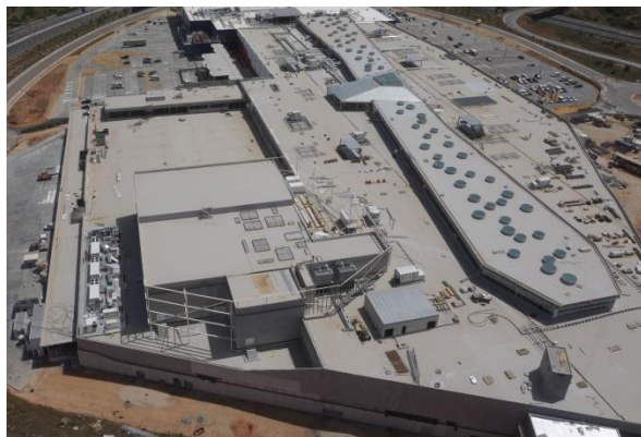
Figura 5.78 – Fotografia aérea da cobertura dos Corpos A, B, D e E, com a impermeabilização aplicada [Fonte:IPP; Data: 04.2017]
