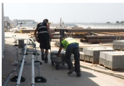
Figura 6.21 – Utilização de carros de transporte sobre a cobertura [Data: 20.06.2017]
