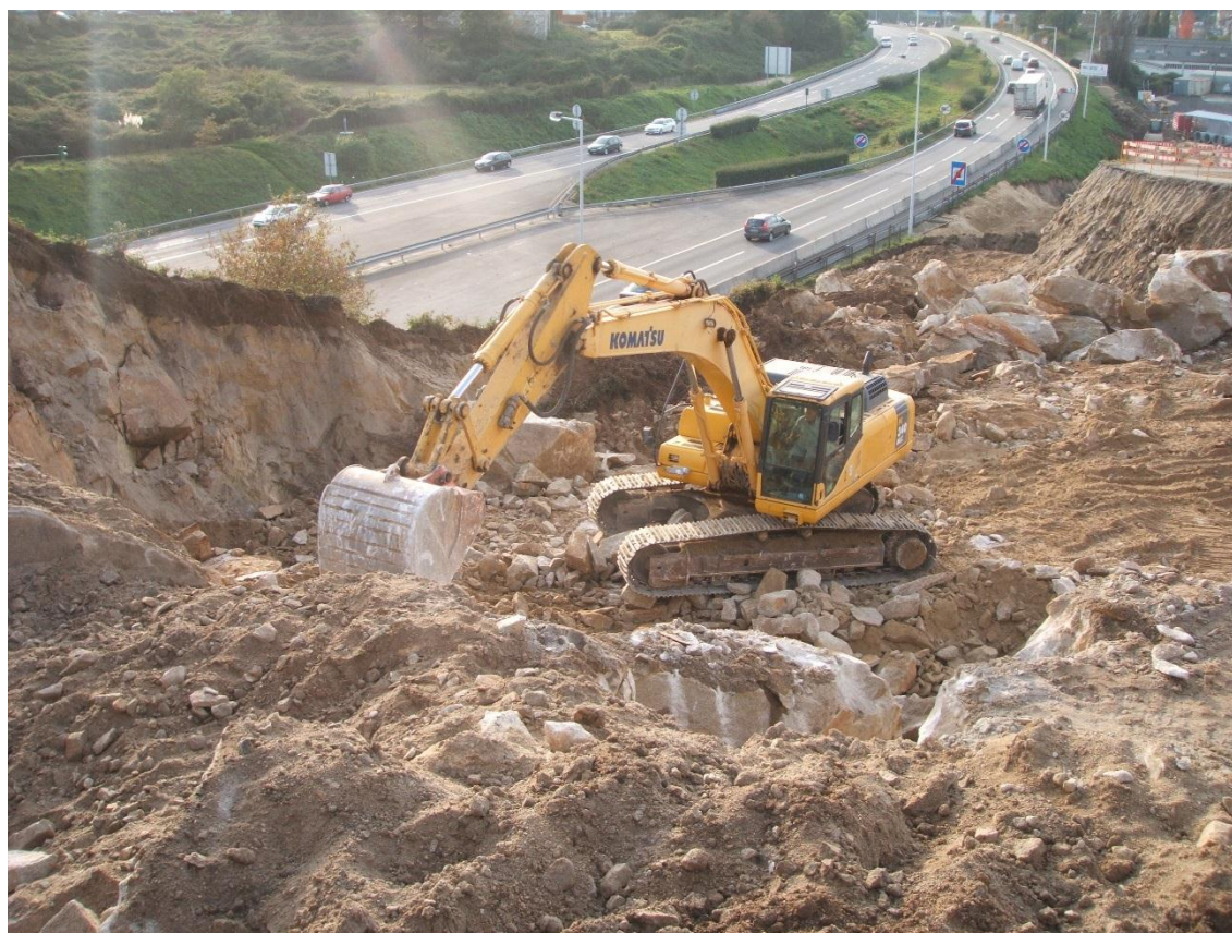
Figura 2.3 – Escavação do Túnel de Águas Santas
