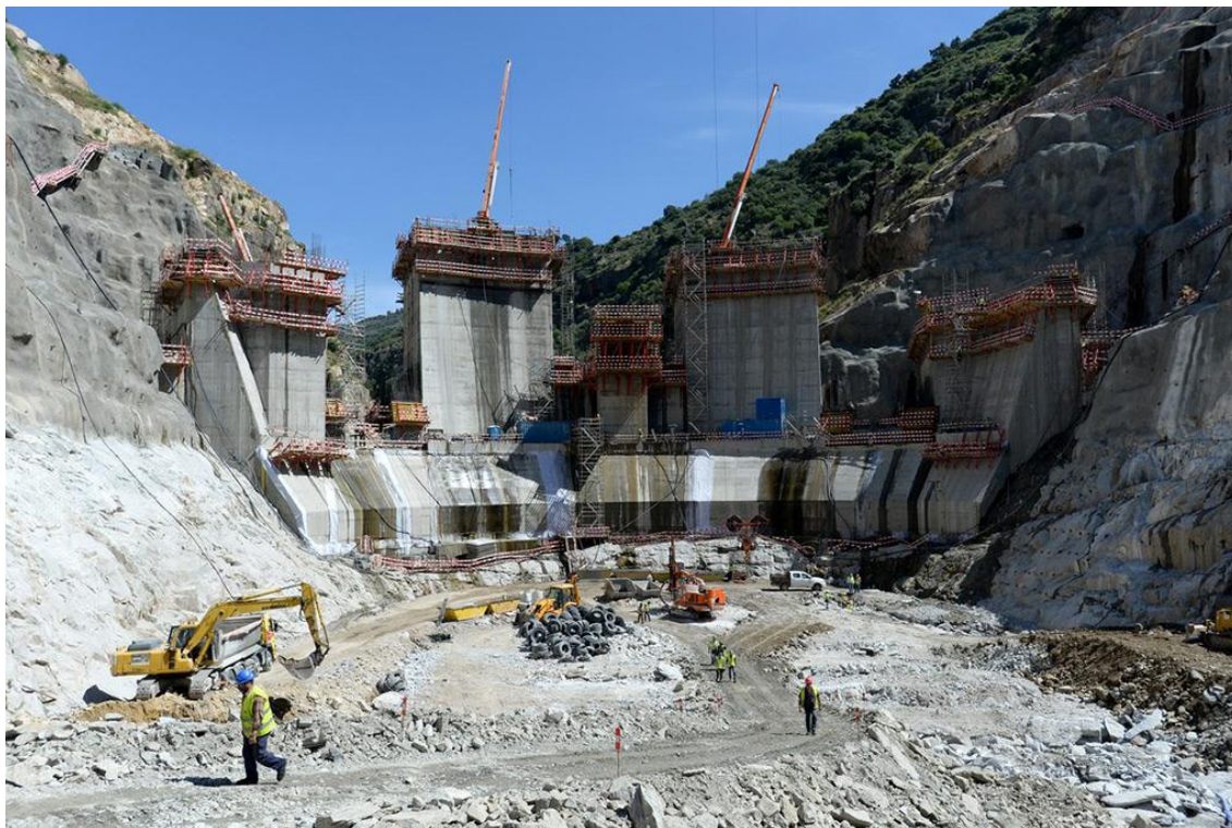
Figura 2.4 – Obra da Barragem do Foz Tua[3]
