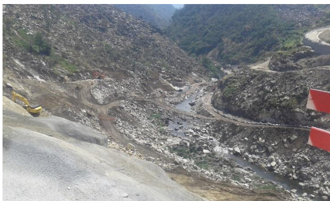
Figura 2.6 – Obra da Barragem do Alto Tâmega
