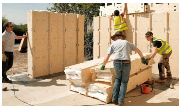
Figura 15 - Montagem de módulos WikiHouse em madeira. Reproduzido de WikiHouse (2022).
