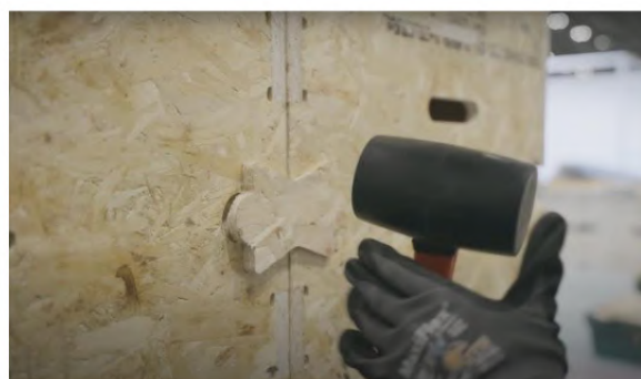
Figura 16 - Estrutura de parede WikiHouse em fase de montagem. Reproduzido de WikiHouse (2022).
