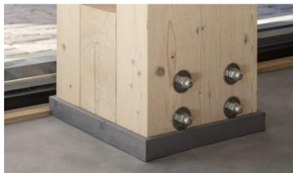
Figura 23- The Demountable Lantern: detalhe de ligação estrutural em madeira. Reproduzido de Studio florisvanderkleij (s.d.).
