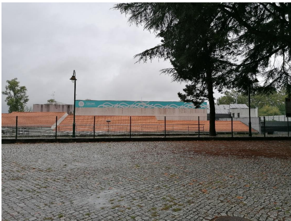
Figura 43: Vista geral do edifício das Piscinas Municipais de Viseu.
