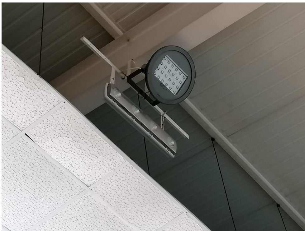
Figura 55: Fornecimento e instalação iluminação LED
