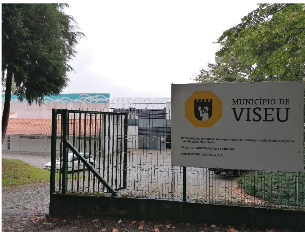
Figura 41: Fachada principal das Piscinas Municipais do Fontelo.
