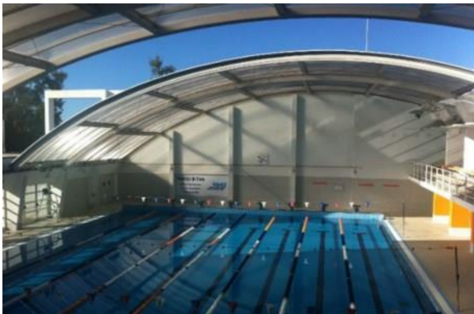
Figura 45: Vista geral do tanque principal.
