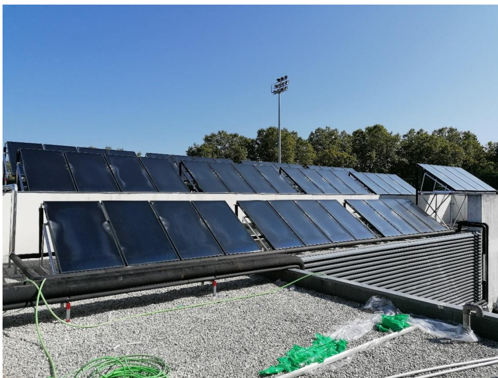
Figura 56: Fornecimento e instalação painéis solar térmico
