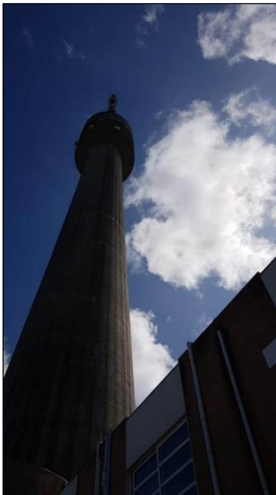
Figura 6.24 - Base da torre de telecomunicação do monte da virgem (acervo do autor).
