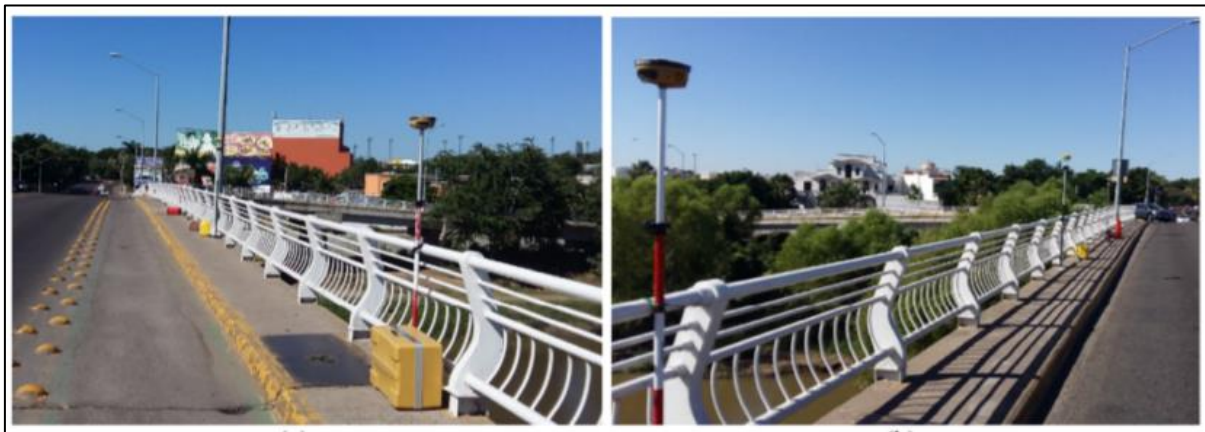
Figura 2.2 - GPS para medição de deslocamento em pontes (Vazquez B. et al. , 2017).
