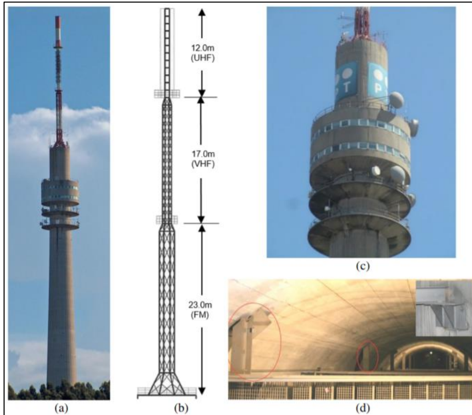
Figura 3.5 - Torre de telecomunicações do Monte da Virgem: (a) vista geral; (b) torre metálica; (c) Pisos técnicos; (d) vista superior do interior do fuste, com vigas metálicas e detalhe de sua conexão no fuste (Ribeiro et al. , 2019).
