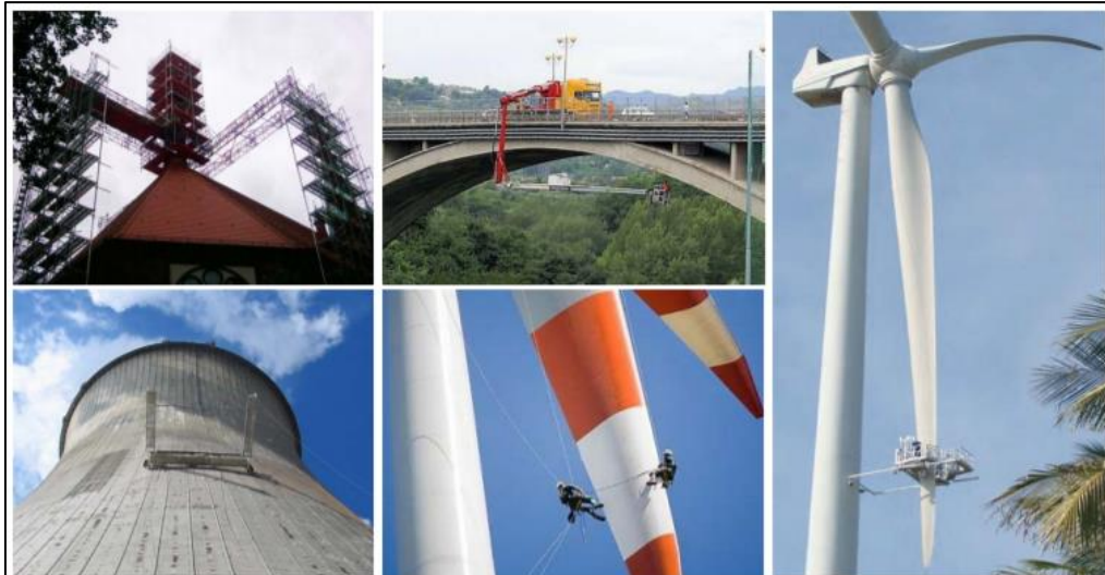
Figura 2.25 Inspeção convencional de grandes estruturas (Hallermann e Morgenthal, 2013).
