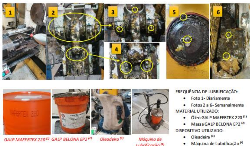
Figura 40- Pontos de Lubrificação
