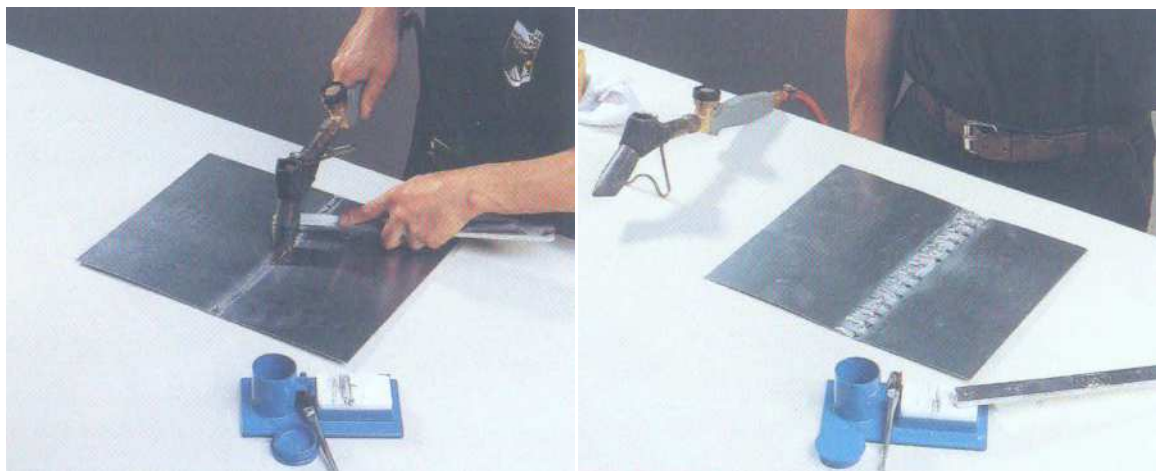
Figura 51 - Execução de soldadura [33]
