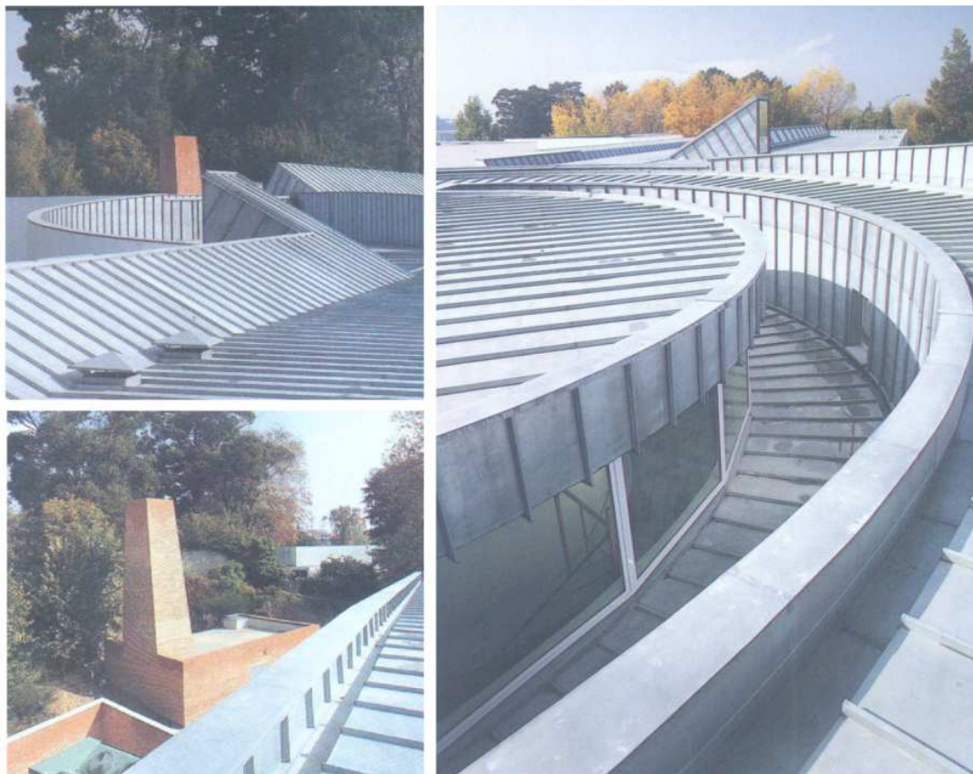
Figura 11 – Cobertura em zinco – Faculdade de Arquitetura do Porto
