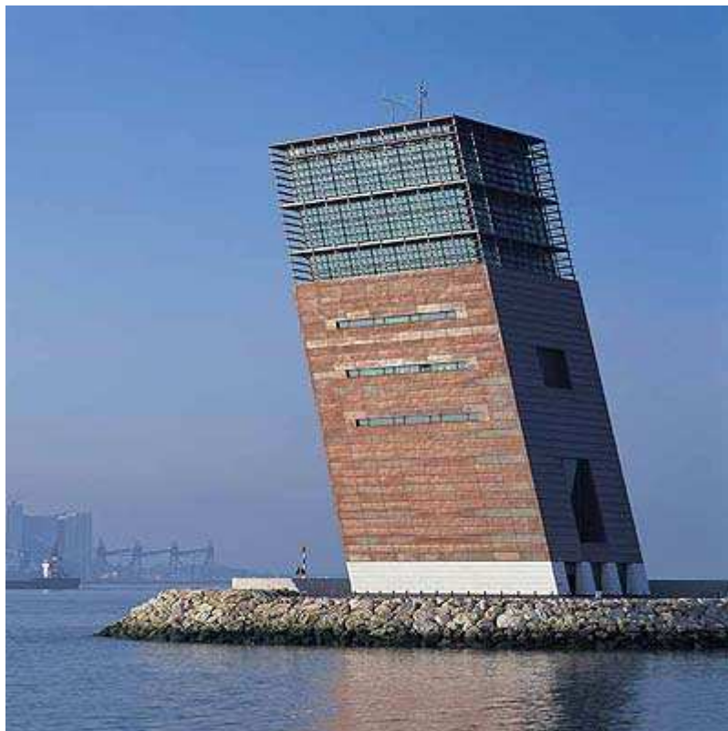
Figura 12 – Fachada em cobre – Centro de Coordenação e Controlo de Tráfego Marítimo e Segurança do Porto de Lisboa
