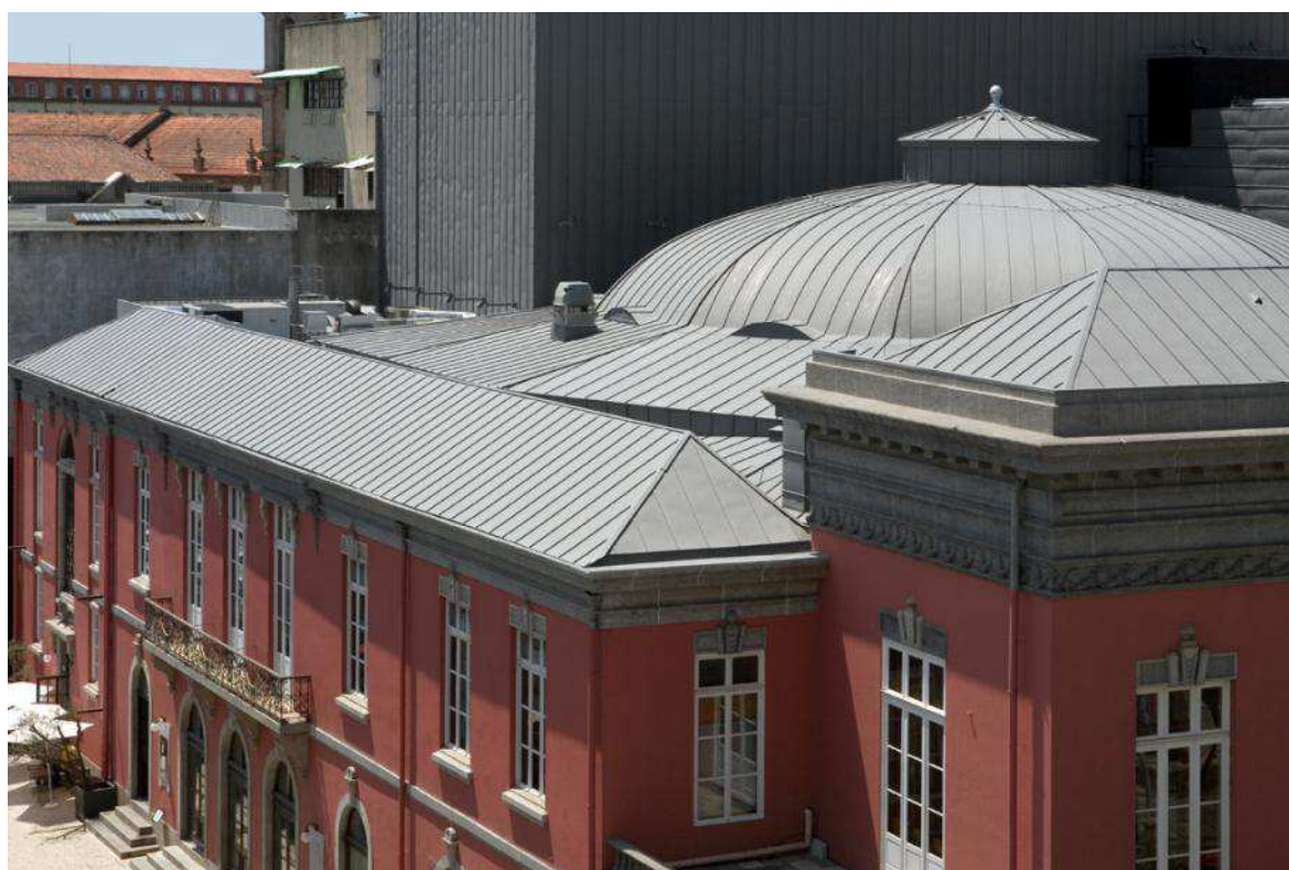
Figura 80 – Reabilitação do Teatro Circo de Braga – Coberturas e fachadas em zinco com sistema de Junta Agrafada
