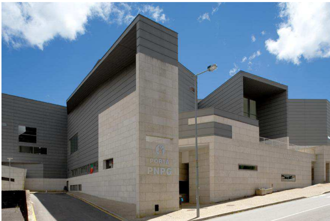
Figura 78 – Parque de feiras e exposições de Montalegre – Fachadas em zinco com sistema de Junta Agrafada
