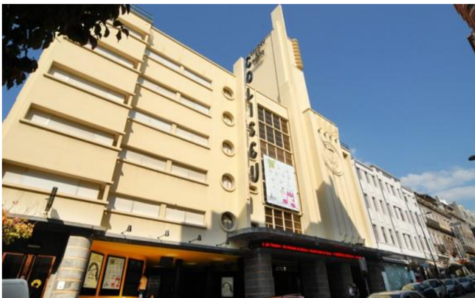
Figura 2.2 – Fachada Frontal do Coliseu do Porto
