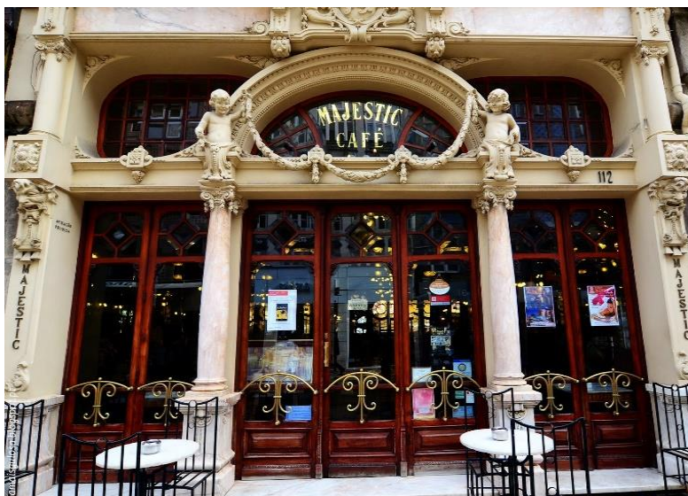
Figura 4.1 – Pormenor da fachada principal do “Café Majestic”
