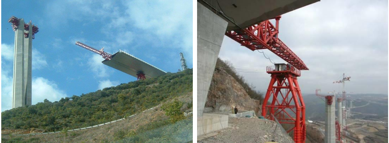
Figura 3.2 - Utilização de Avant-bec no lançamento incremental
