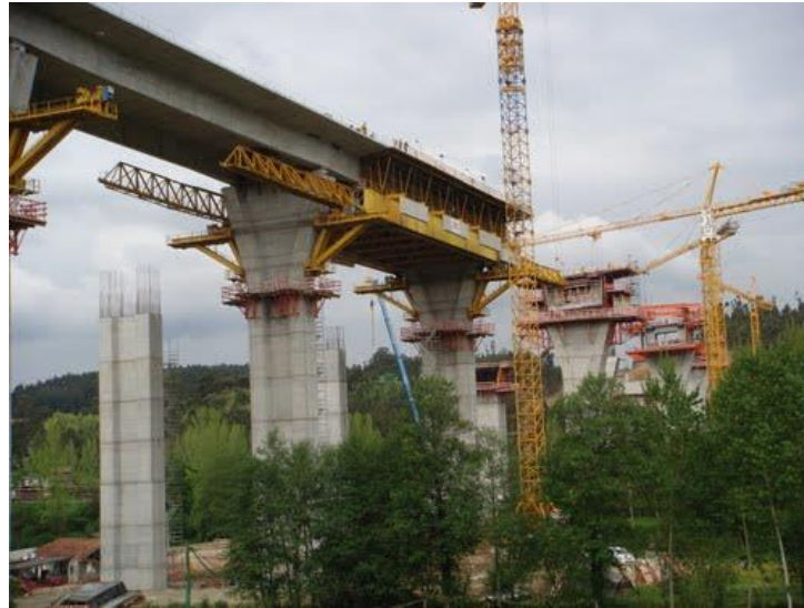
Figura 3.4 - Viga de lançamento inferior
