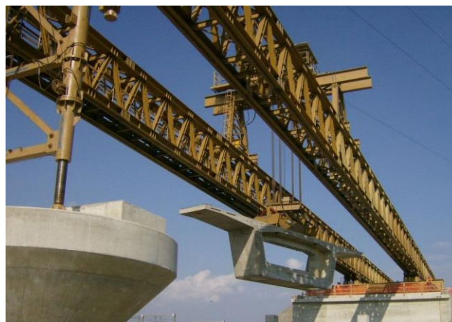
Figura 3.5 - Viga de lançamento de assemblagem
