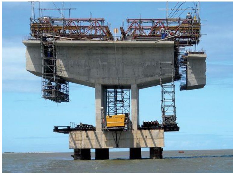
Figura 3.8 - Construção com aduelas pré-fabricadas
