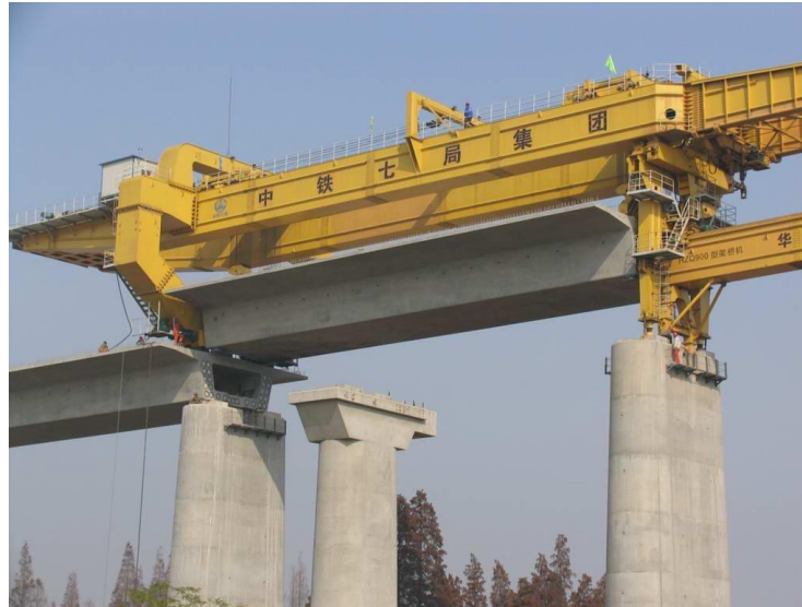
Figura 3.3 - Viga de lançamento superior
