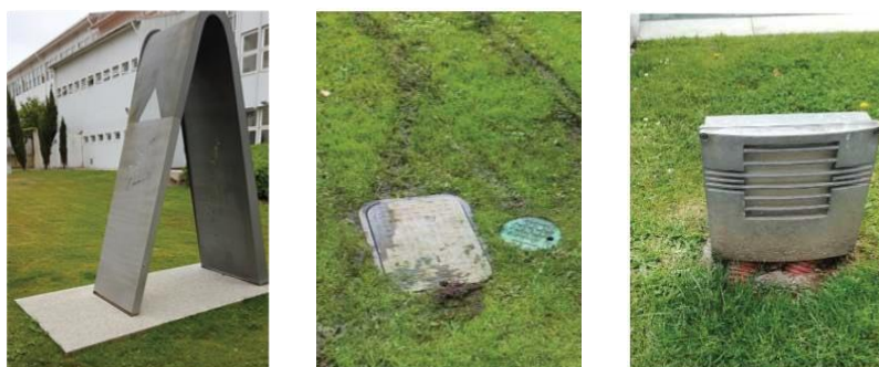
Figura 2.12 – Elementos pontuais diversos existentes na cobertura do parque subterrâneo.
