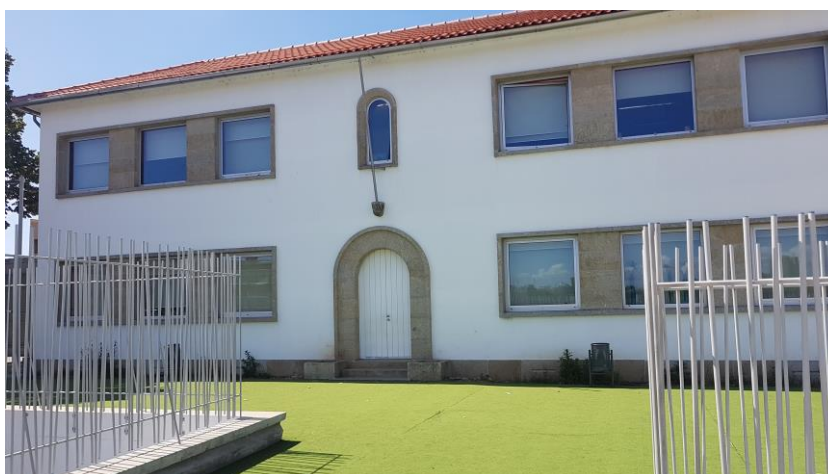
Figura 4.3 – Fachada do edifício original da escola.
