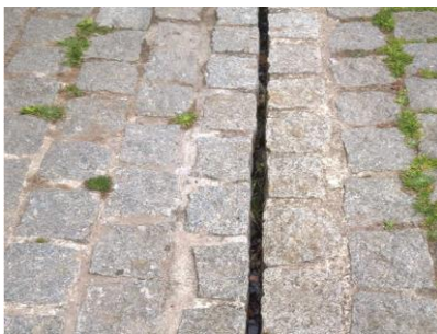
Figura 2.20 – Canais de drenagem de águas pluviais.
