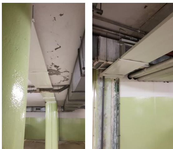
Figura 2.21 – Caleiras metálicas instaladas no parque subterrâneo sob a zona de dilatação.
