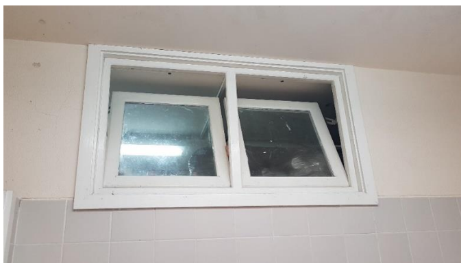
Figura 4.49 – Envidraçados entre a Divisão B (arrumos) e Divisão C (instalações sanitárias).
