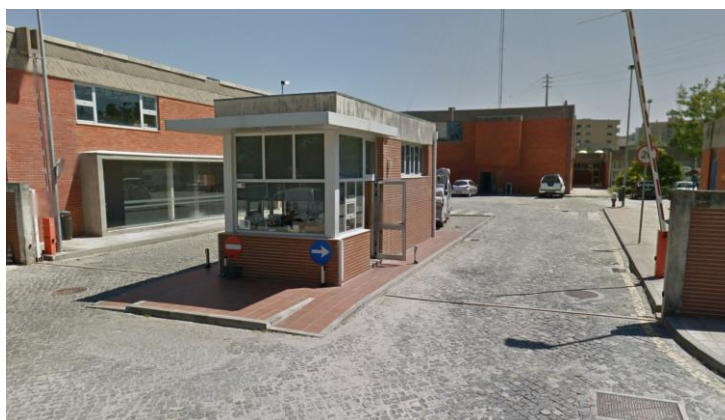
Figura 2.1 – Armazéns Gerais da Câmara Municipal de Matosinhos.
