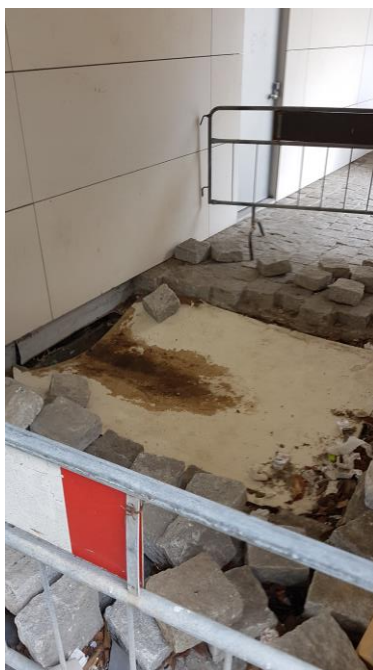
Figura 2.17 – Registo fotográfico do remate entre revestimento em pedra/fachada.
