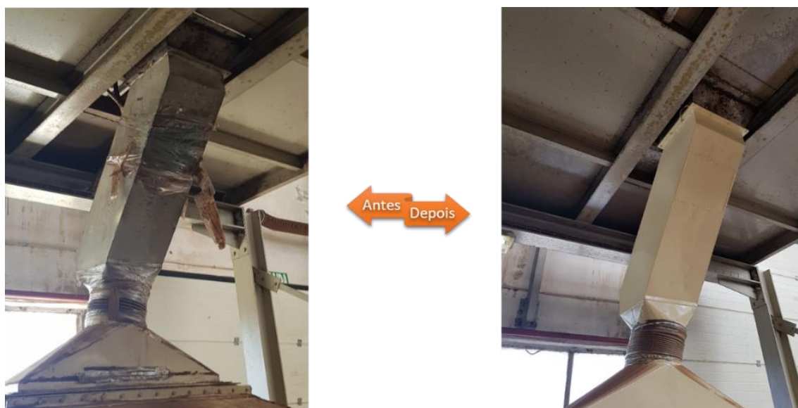
Figura 25 - Reposição das tubagens
