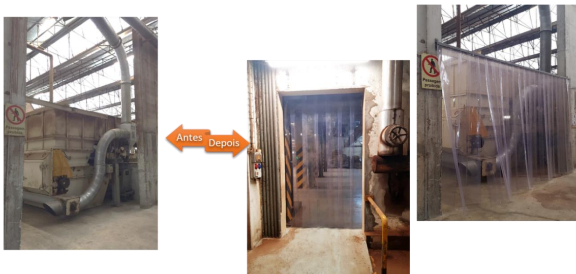
Figura 20 - Isolamento do pavilhão
