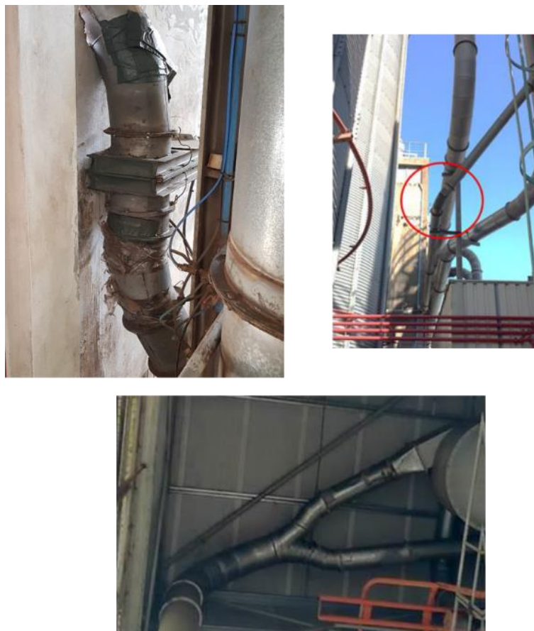
Figura 26 - Reparação das tubagens
