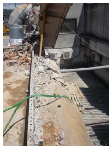
Imagem 40: Escoramentos dos arcos a demolir
