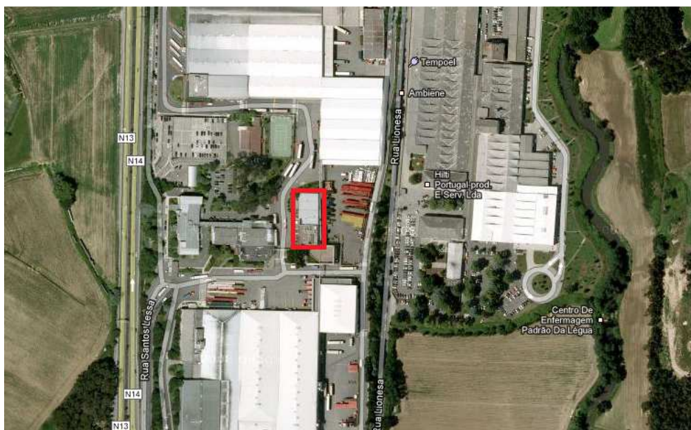
Imagem 54: Localização do edifício a demolir
