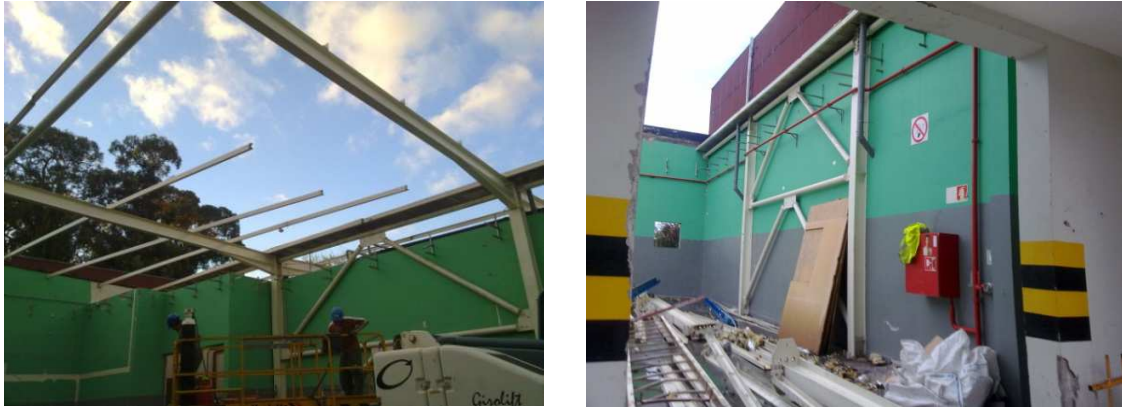
Imagem 62: Corte da estrutura metálica do armazém
