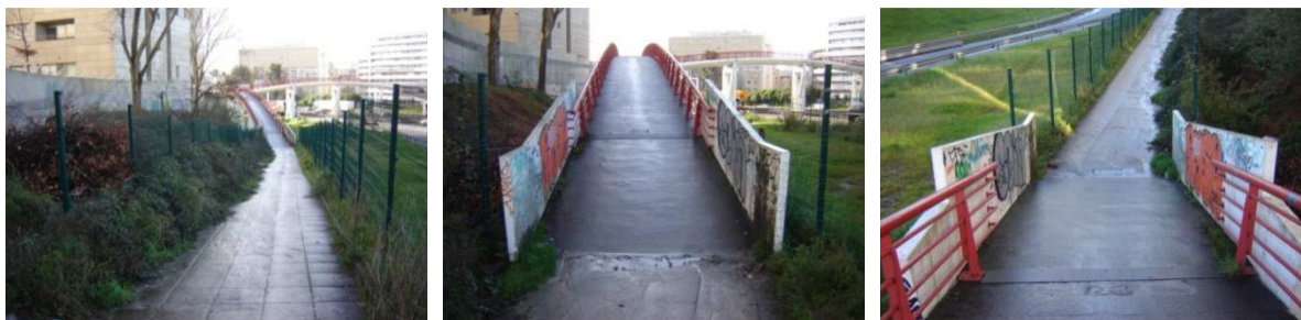
Acesso à passagem pedonal a vedar (Av. Do Bessa)
