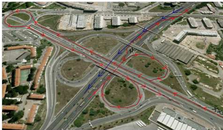
Imagem 116: Corte e desvio de trânsito para a elevação do 4 tramo
