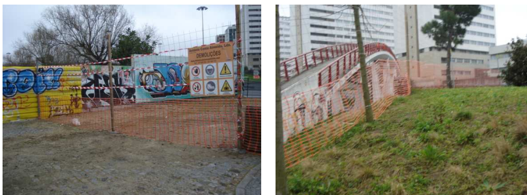
Imagem 103: Vedação do local da obra
