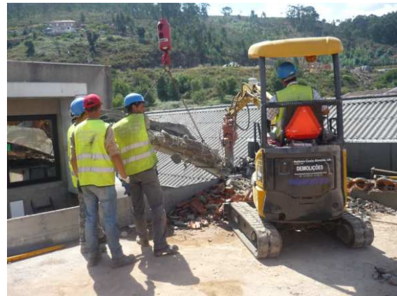
Imagem 44: Demolição dos encontros
