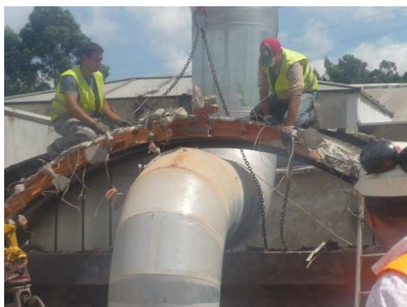
Imagem 39: Colocação dos cabos da grua nos "arcos" a içar
