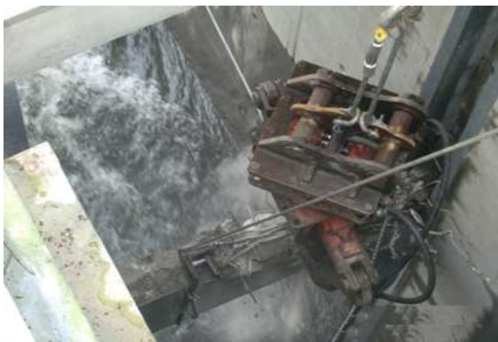
Imagem 96: Remoção da comporta (3)
