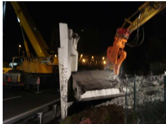
Imagem 119: Demolição do 4º pilar
