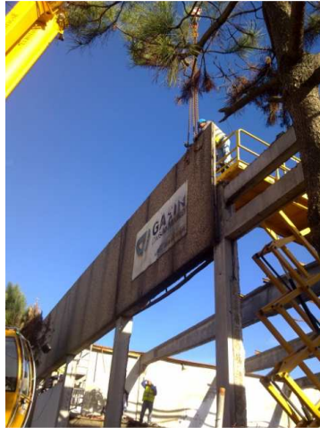
Imagem 76: Auto grua a auxiliar na remoção das placas pré-fabricadas
