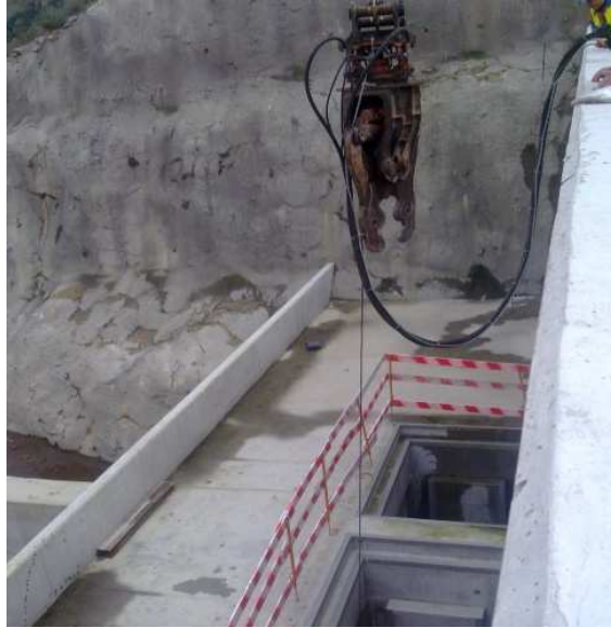
Imagem 92: Posicionamento da tesoura na abertura de acesso para remoção das comportas
