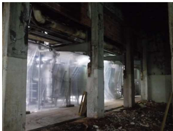
Imagem 30: Após demolição das paredes em betão
