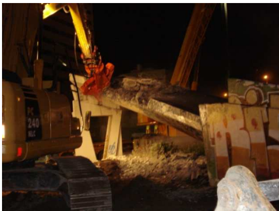
Imagem 120: Demolição do tramo de encontro
