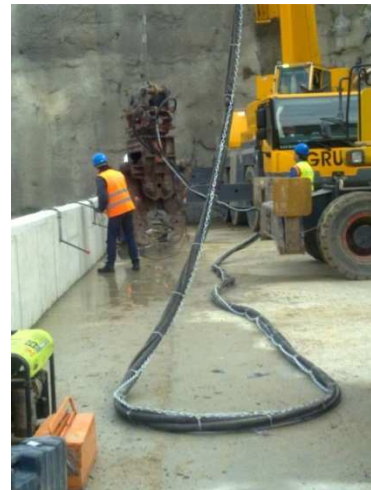
Imagem 88: Tesoura com tubos hidráulicos de 20 metros
