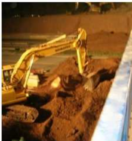
Imagem 48: Colocação de saibro sobre a manta geotêxtil
