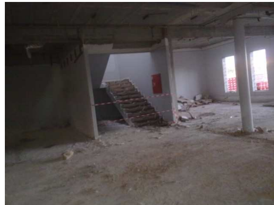
Imagem 64: Edifício pronto a demolir (Rês do Chão)
