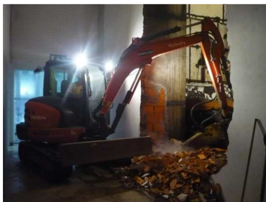
Imagem 26: Mini-escavadora a proceder à demolição da parede de alvenaria central
