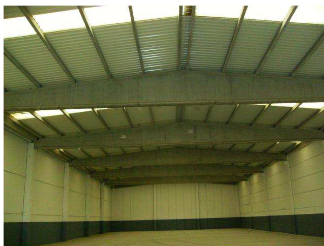
Imagem 70: Estrutura típica dos armazéns na Zona Industrial da Varziela
