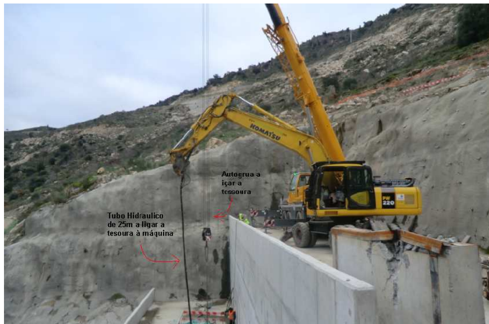
Imagem 91: Tesoura desacoplada e içada por auto grua
