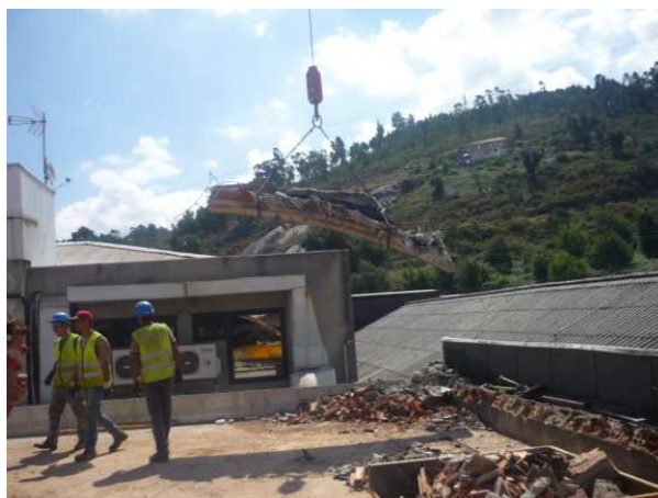
Imagem 45: Laterais dos arcos a serem içados
