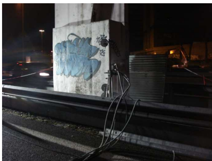
Imagem 115: Cavalete do fio diamantado para corte do pilar
