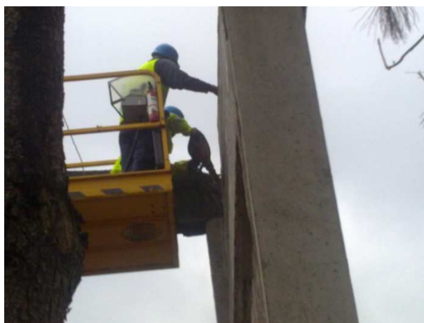
Imagem 78: Picagem da ligação a viga/pilar para se aceder ao ferrolho
