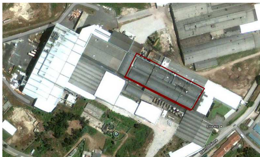
Imagem 31: Cobertura a demolir
