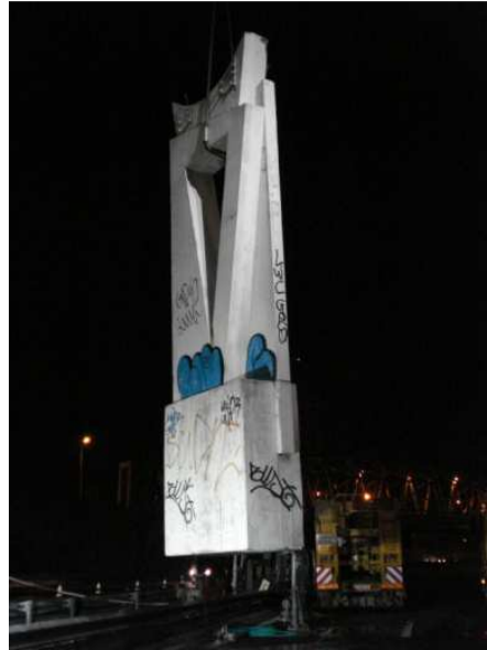
Imagem 118: Elevação do pilar cortado para colocação em camião
