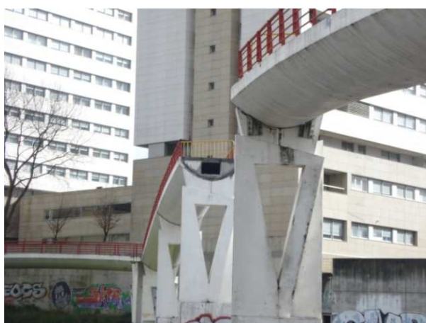
Imagem 107: Passagem Pedonal após remoção do 1º tramo
