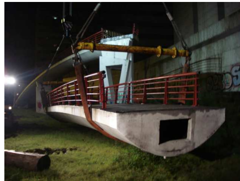
Imagem 112: Colocação do 3º tramo na berma
