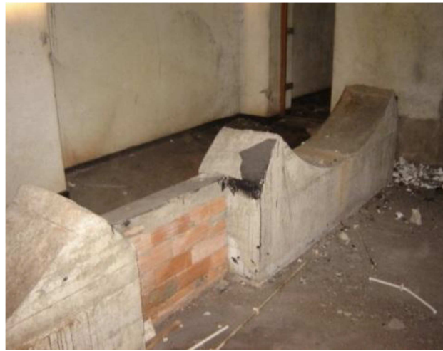
Imagem 23: Bases em betão armado, onde assentavam as cubas
