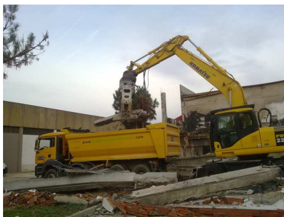
Imagem 80: Carga do RCD para encaminhamento a vazadouro
