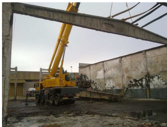
Imagem 77: Cabos da grua em tensão enquanto se efetuam os trabalhos preliminares para remoção da viga
