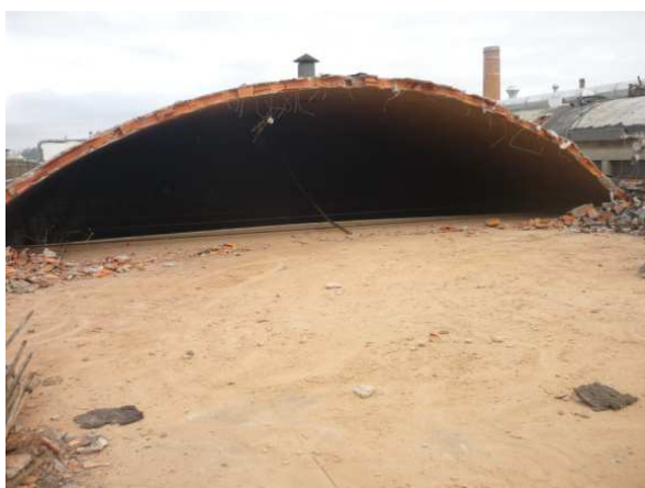
Imagem 35: Vista interior do armazém, já com avanço da plataforma.
