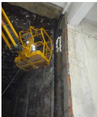
Imagem 28: Remoção do revestimento existente nas paredes em plataforma “tipo tesoura”
