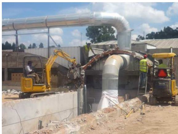
Imagem 37: Mini escavadora, sobre as plataformas dos cimbres, a demolir o encontro da cobertura como o edifício adjacente.
