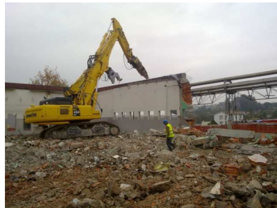
Imagem 65: Demolição da zona do armazém
