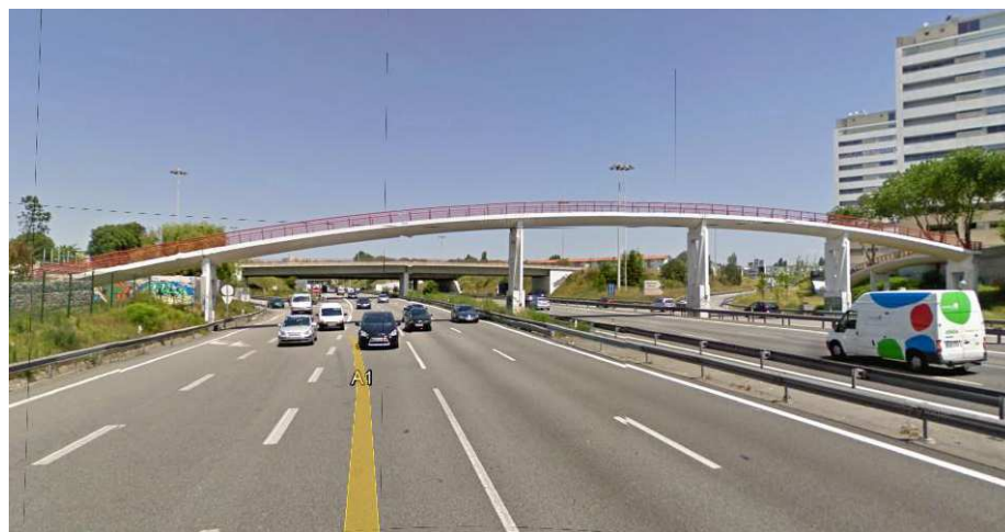
Imagem 97: Vista da Passagem Pedonal a demolir
