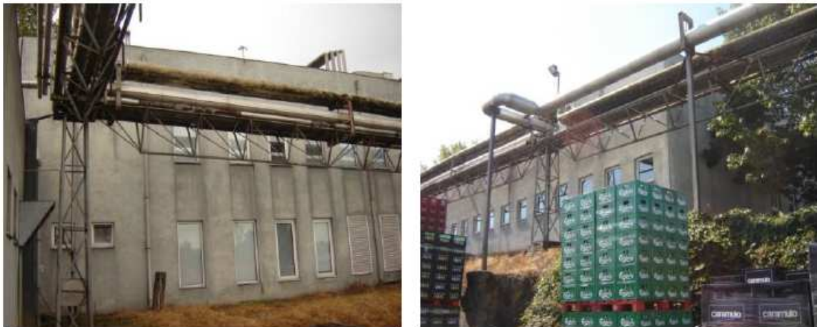
Imagem 57: Pipe-rack existente no tardo do edifício (a manter)
