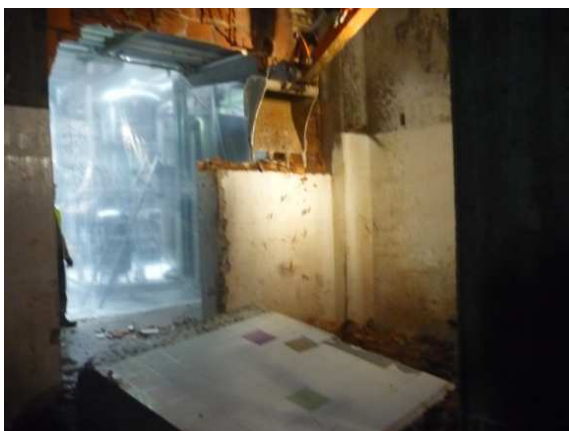
Imagem 29: Demolição das paredes após corte com serra hidráulica
