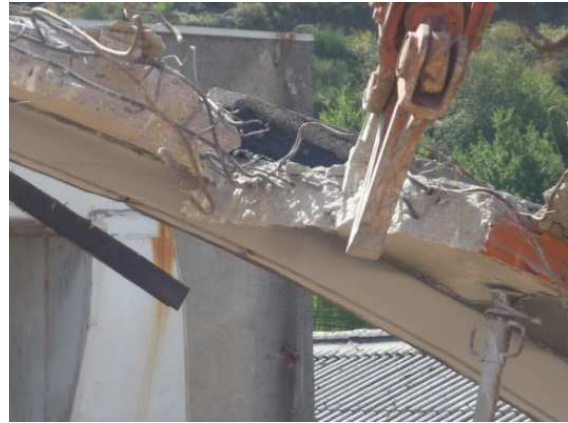
Imagem 43: Corte das laterais do arco a içar
