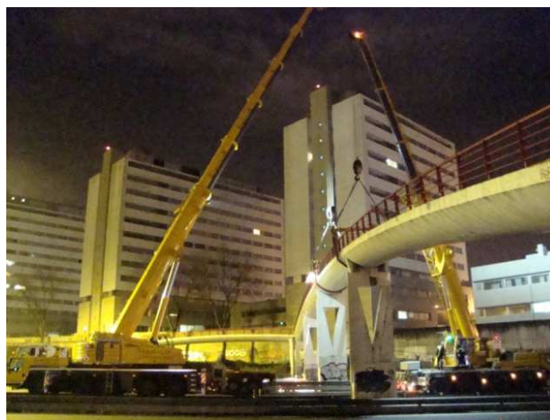
Imagem 105: Início da remoção do 1º tramo
