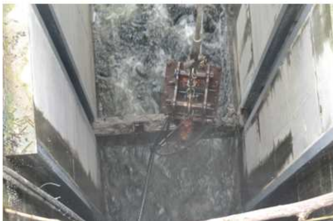
Imagem 95: Remoção de comporta (2)
