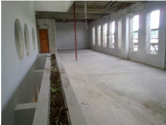
Imagem 63: Edifício pronto a demolir (Piso 1)
