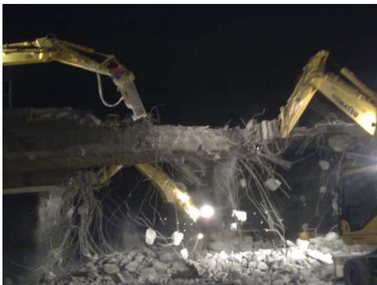
Imagem 53: Faixa com 1m não demolida para não ocorrer o desmoronamento descontrolado da estrutura
