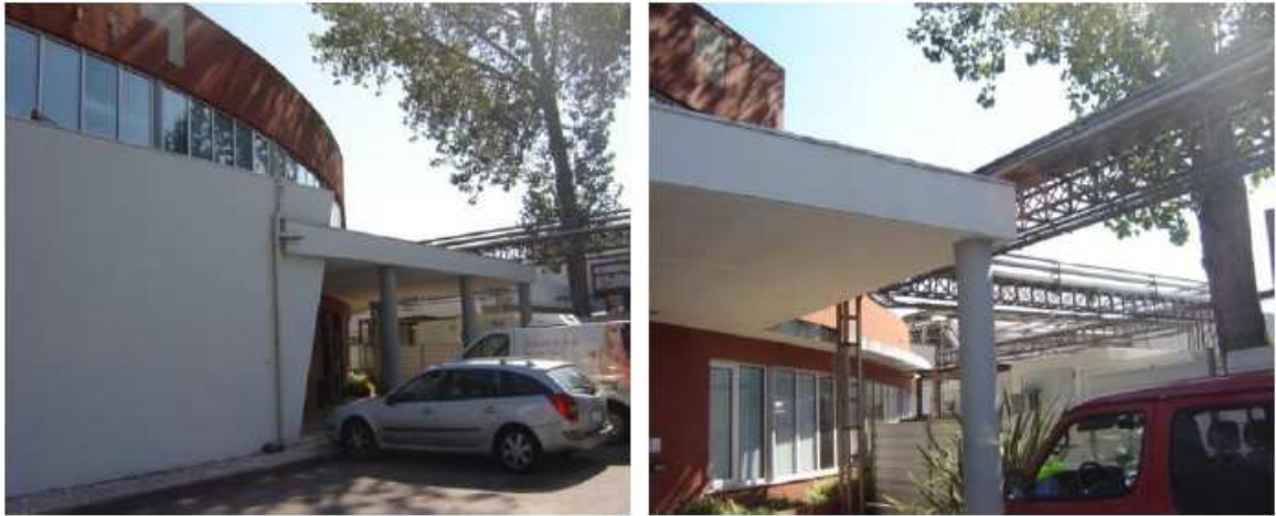
Imagem 56: Entrada para a parte administrativa e pipe-rack existente na lateral do Edifício
