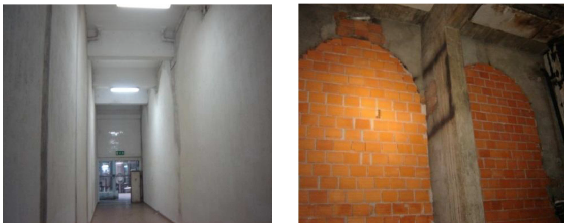
Imagem 21: As 3 paredes de alvenaria a demolir. Vista pelo exterior da adega (esq.)
