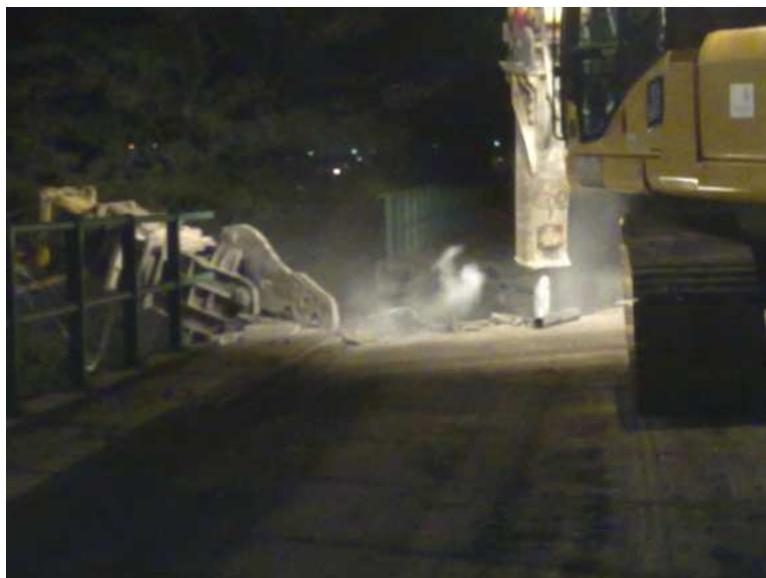
Imagem 52: Vista sobre o tabuleiro do trabalho de demolição do martelo hidráulico e da tesoura demolidora
