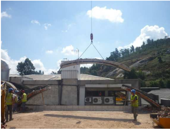
Imagem 42: Parte central do arco a ser içado
