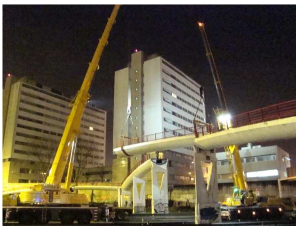
Imagem 106: Remoção do 1º tramo
