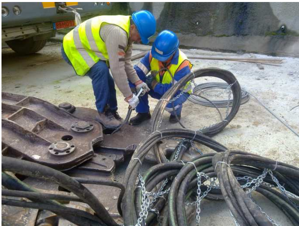
Imagem 87: Ligação dos tubos hidráulicos à tesoura
