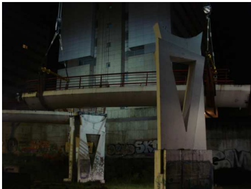
Imagem 111: Remoção do 3º tramo
