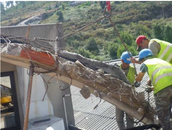
Imagem 41: Colocação dos cabos da grua nas laterais/encontros dos "arcos" içados
