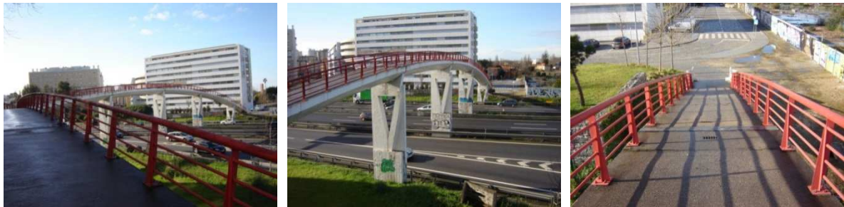
Passagem pedonal a demolir
