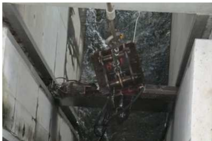
Imagem 94: Remoção da comporta (1)
