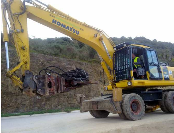
Imagem 85: Escavadora de rodas utilizada
