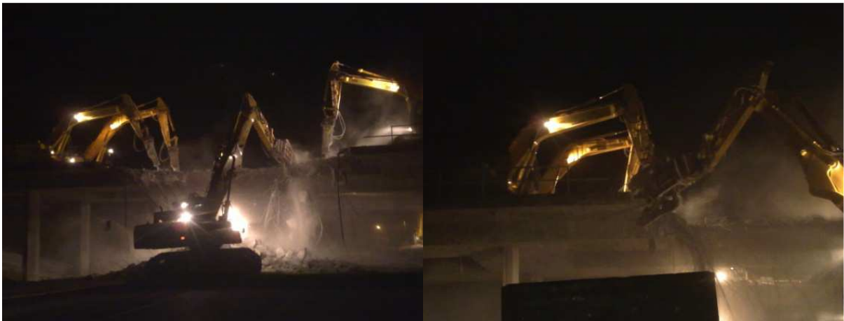
Imagem 50: Demolição da parte central do tabuleiro
