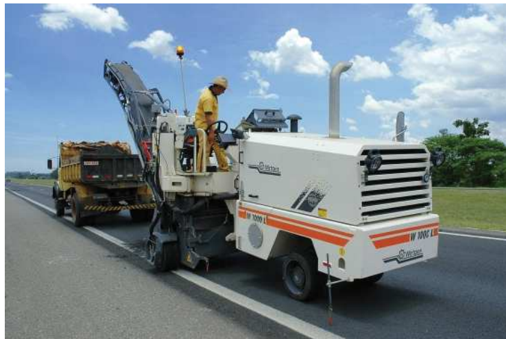
Imagem 12: Fresa e caminhão Basculante (Engenharia e Construção, 2009)
