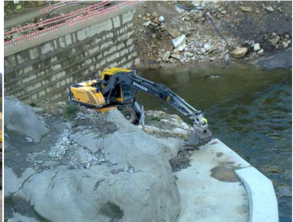
Imagem 86: Escavadora de rastos utilizada
