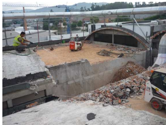
Imagem 38: Mini pás carregadoras a encaminhar os resíduos para o corredor central.
