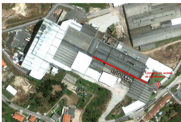
Imagem 32: Corredor de acesso às instalações onde se estabilizou a plataforma elevatória e a auto grua
