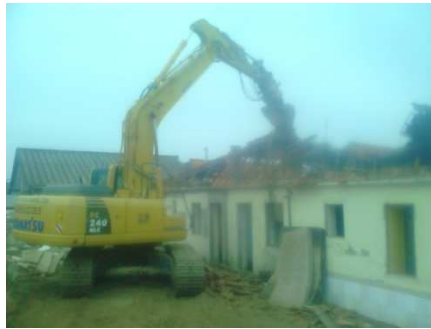
Imagem 17: Demolição de moradia em Vila Nova de Gaia
