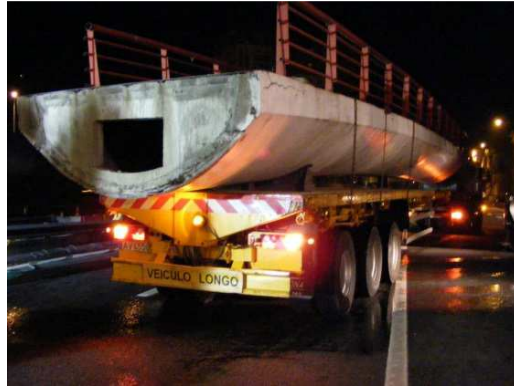
Imagem 110: Colocação do 2º tramo em camião para transporte a vazadouro
