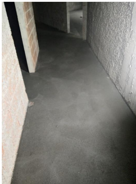
Figura 5.12 – Aspeto final do pavimento
