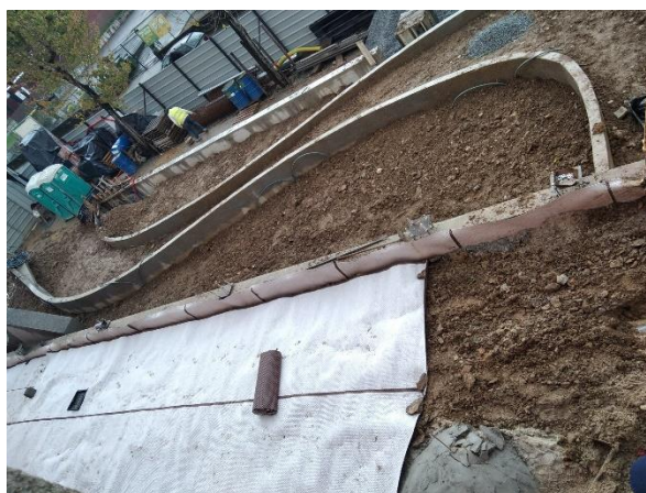
Figura 5.36 – Colocação da manta pitonada impermeabilizante
