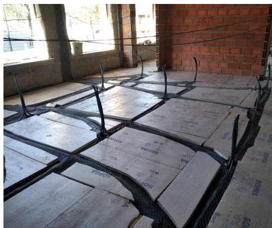
Figura 5.18 – Colocação da placa de poliestireno extrudido
