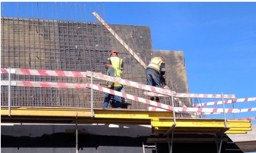
Figura 5.44 – Colocação da armadura e da régua
