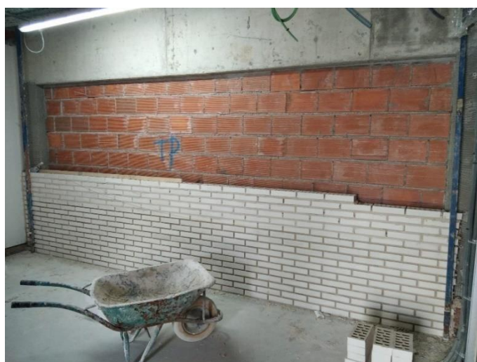
Figura 5.29 – Elevação da parede de alvenaria
