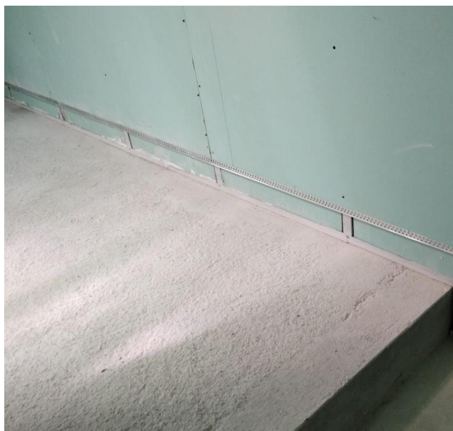
Figura 5.26 – Colocação das cantoneiras perfuradas de ângulo
