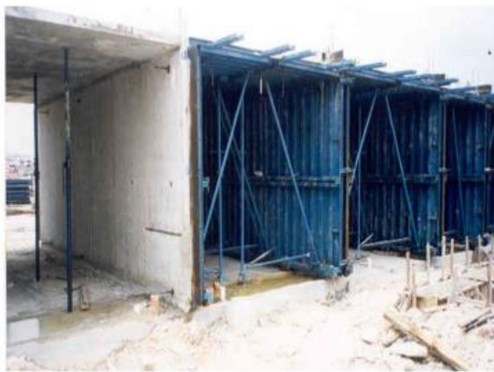
Figura 3.12 – Sistema de cofragem pesada (adaptado [22])
