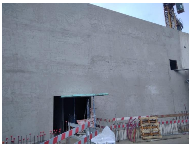
Figura 5.6 – Aspeto final da aplicação do reboco
