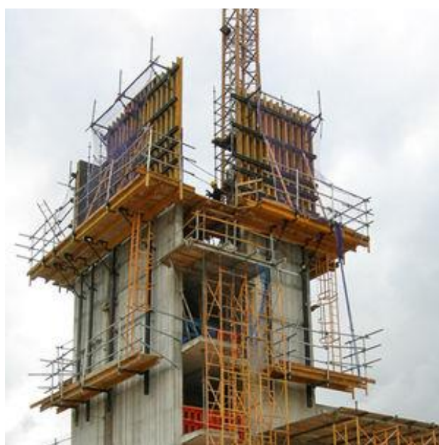
Figura 3.11 – Cofragem Trepante [21]
