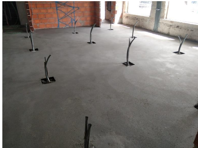
Figura 5.20 – Acabamento do pavimento de piso
