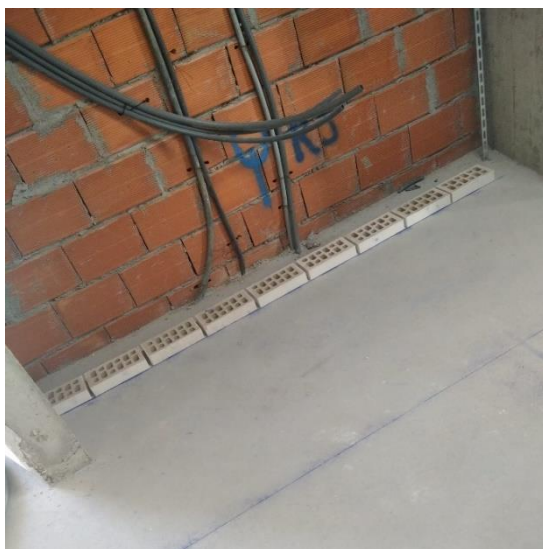
Figura 5.28 – Marcação da primeira fiada
