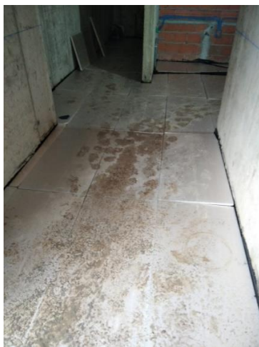
Figura 5.10 – Colocação das placas de isolamento térmico
