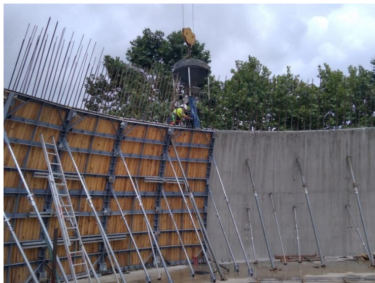
Figura 5.54 – Betonagem da parede
