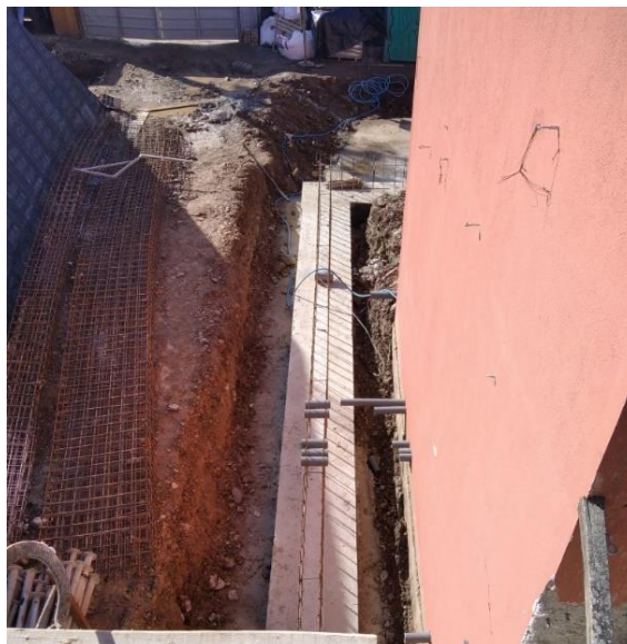
Figura 5.31 – Colocação dos negativos
