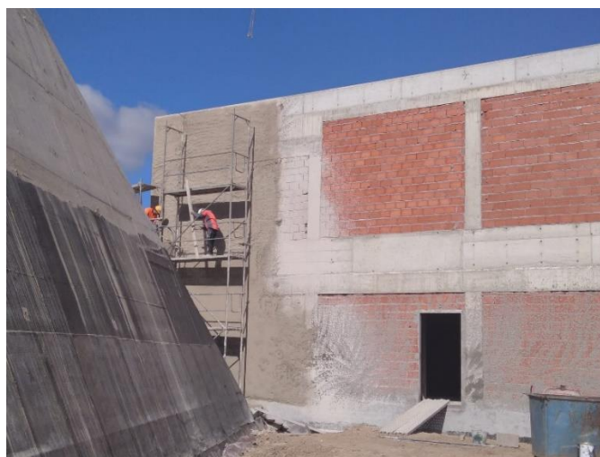
Figura 5.5 – Aplicação do reboco de desempenho
