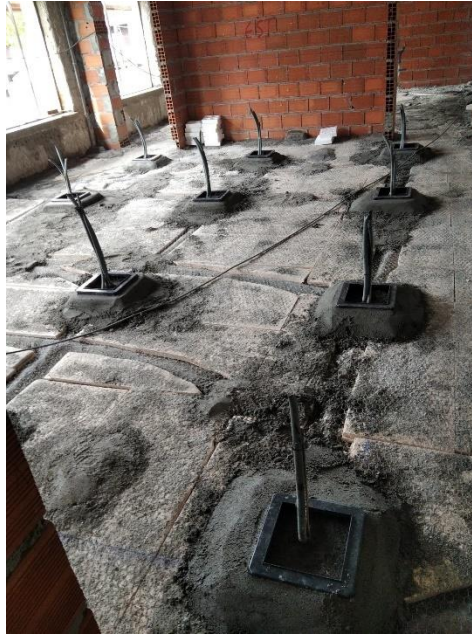
Figura 5.19 – Ajuste das caixas de pavimento
