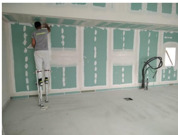
Figura 5.25 – Execução das juntas em banda de papel
