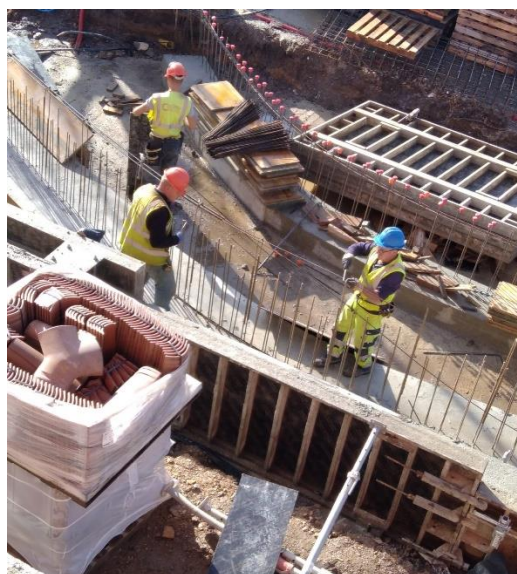
Figura 5.32 – Execução da amarração das armaduras
