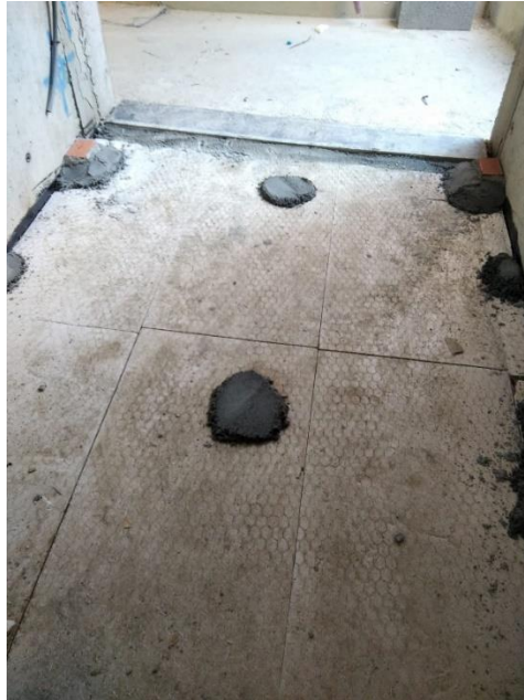
Figura 5.11 – Colocação da rede galvanizada
