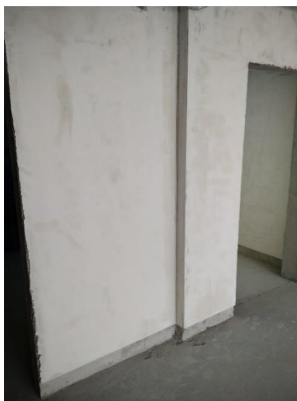
Figura 5.16 – Argamassa de gesso com acabamento estanhado
