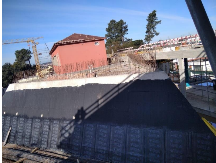
Figura 5.40 – Paredes executadas do 1º nível acima do piso 0
