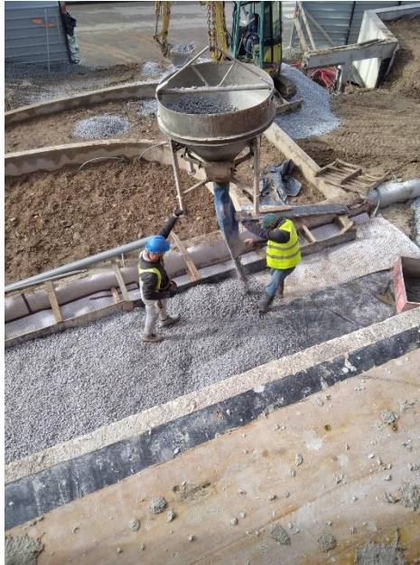
Figura 5.37 – Colocação da camada de agregado britado
