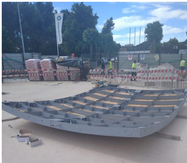
Figura 5.48 – Módulo de cofragem interior
