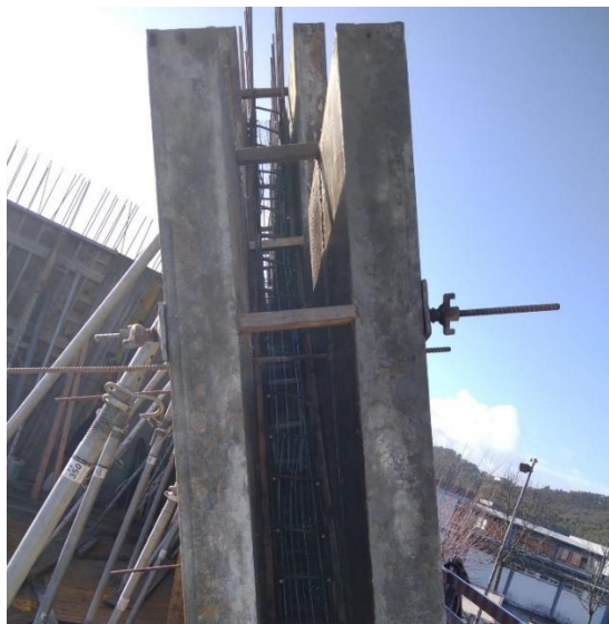
Figura 5.45 – Colocação das ancoragens
