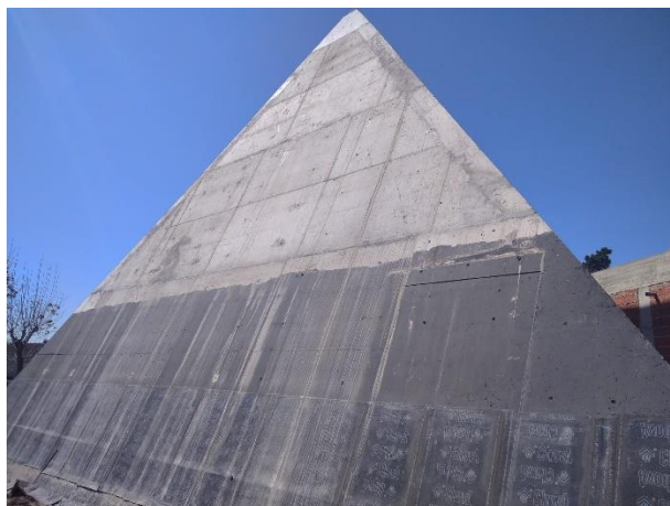
Figura 5.47 – Aspeto final do módulo piramidal
