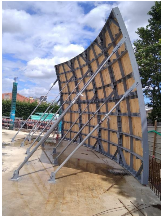
Figura 5.50 – Escoramento dos módulos de cofragem
