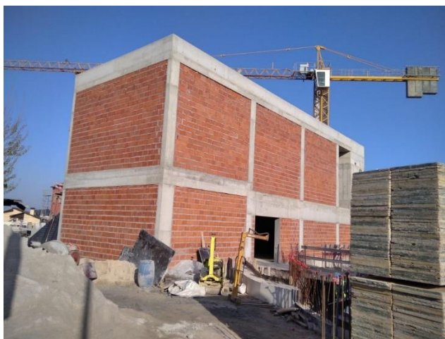
Figura 5.4 – Finalização das paredes de alvenaria
