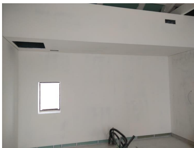
Figura 5.27 – Emassamento das paredes de gesso cartonado
