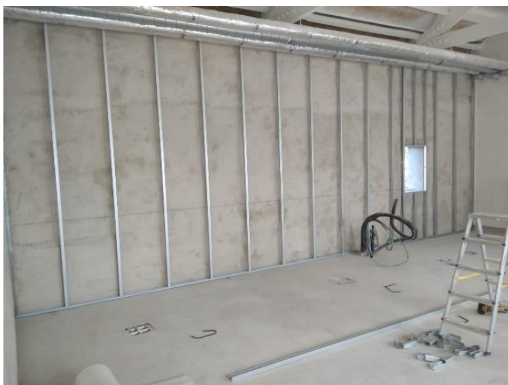
Figura 5.21 – Montagem da estrutura metálica
