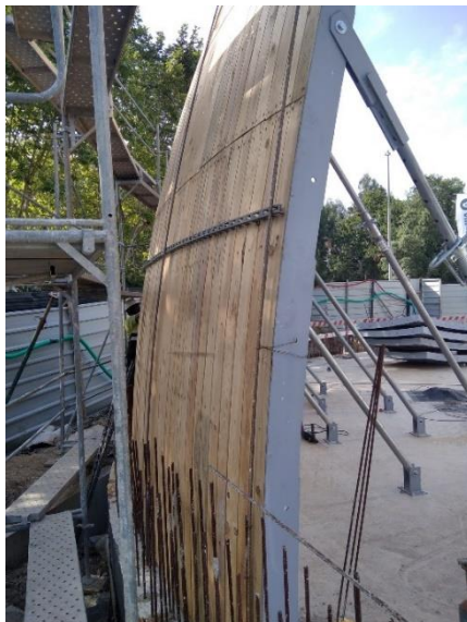
Figura 5.51 – Colocação dos espaçadores
