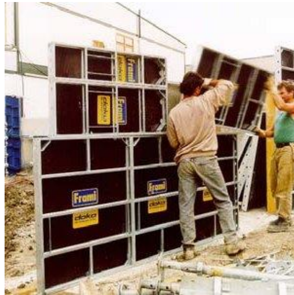
Figura 3.8 – Montagem do sistema de painéis [18]
