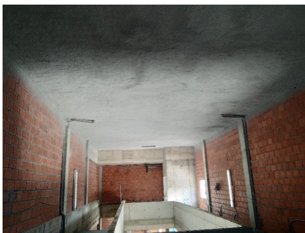
Figura 5.8 – Aspeto final da argamassa antifogo
