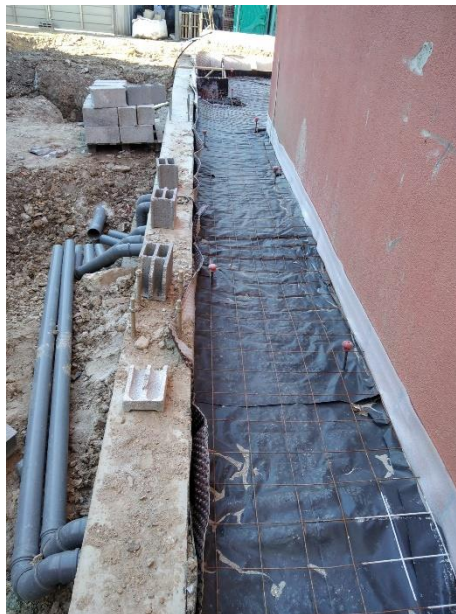
Figura 5.38 – Colocação do filme plástico e da malha em aço quadrada
