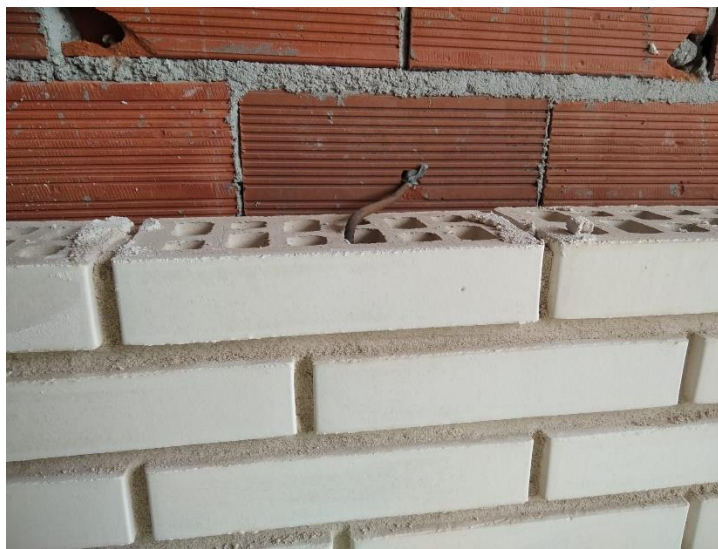
Figura 5.30 – Aplicação dos grampos metálicos
