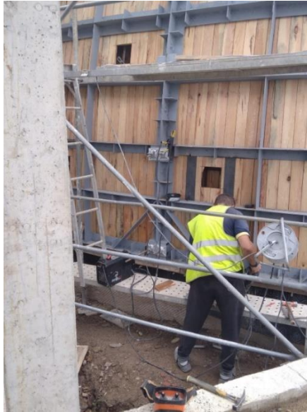
Figura 5.53 – Abertura das “janelas” na cofragem exterior
