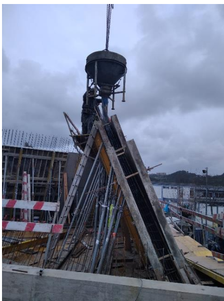
Figura 5.46 – Betonagem da parede
