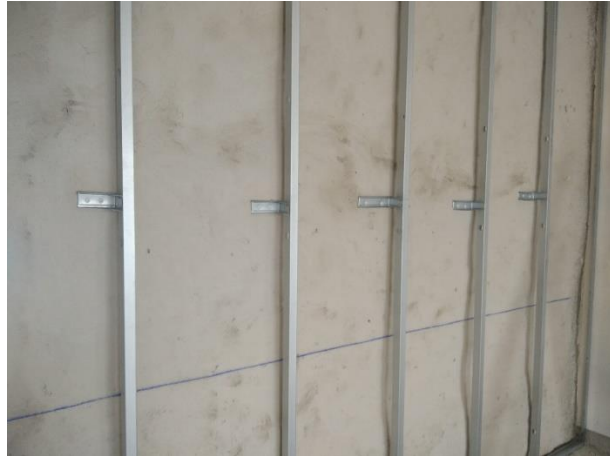
Figura 5.22 – Fixação dos perfis verticais
