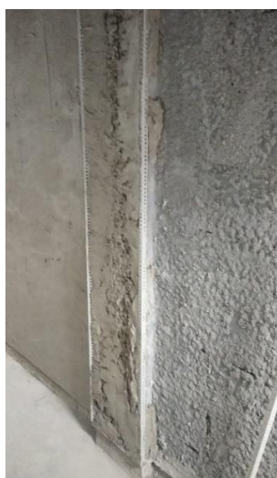
Figura 5.14 – Colocação de perfis em PVC
