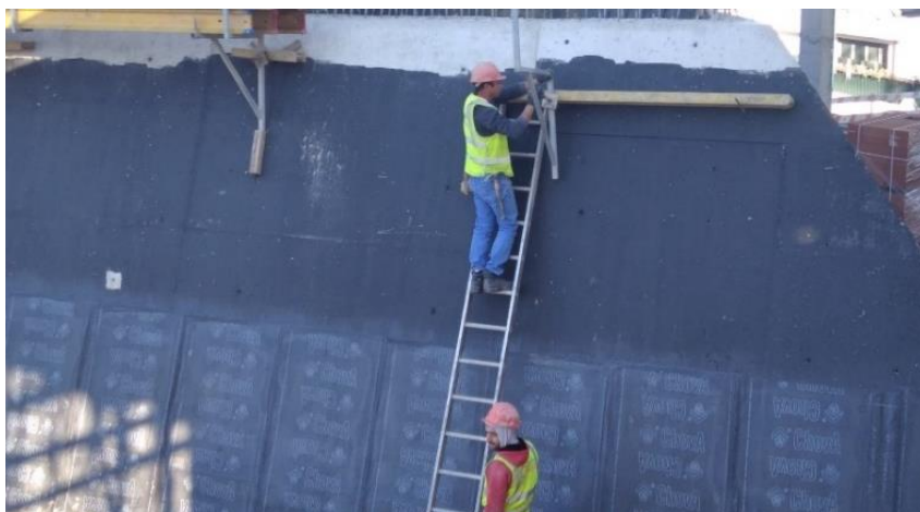
Figura 5.42 – Fixação das poleias
