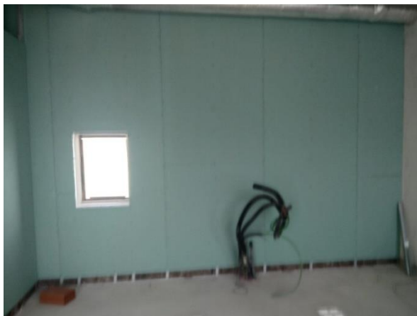
Figura 5.24 – Colocação dos painéis de gesso cartonado
