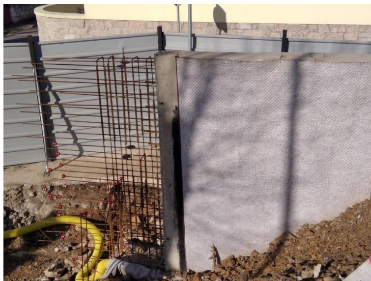
Figura 5.33 – Colocação das camadas impermeabilizantes
