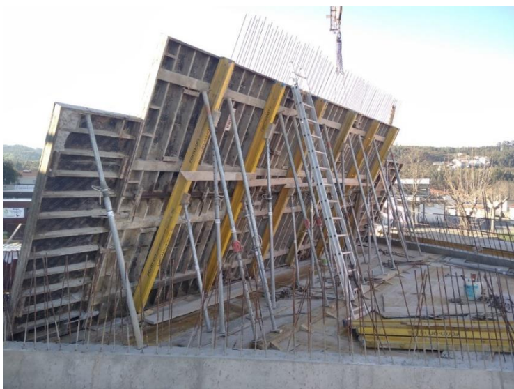
Figura 5.43 – Escoramento da cofragem interior
