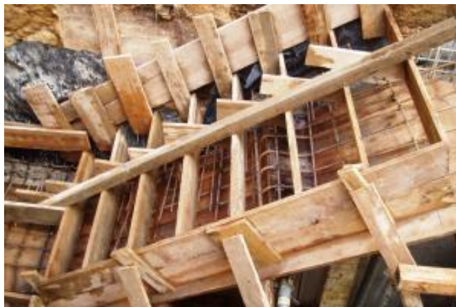
Figura 3.6 – Cofragem tradicional de escadas [15]
