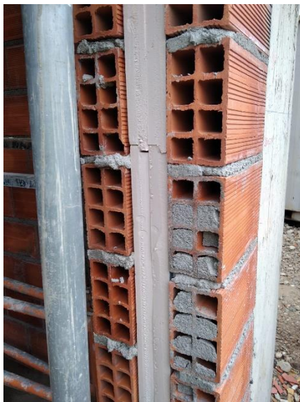
Figura 5.3 – Pano de alvenaria dupla
