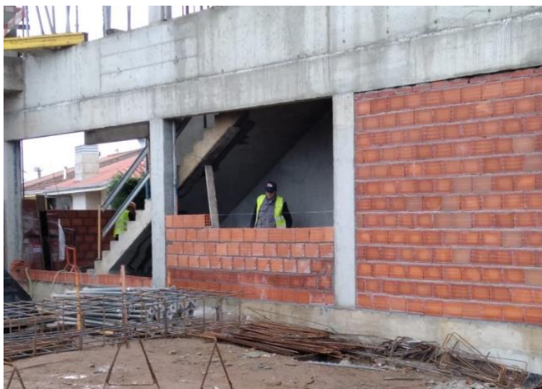
Figura 5.1 – Execução da primeira fiada e elevação das fiadas
