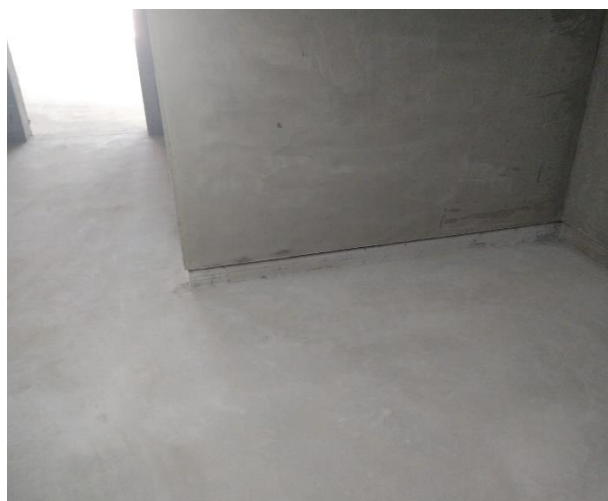
Figura 5.15 – Aplicação da argamassa mista
