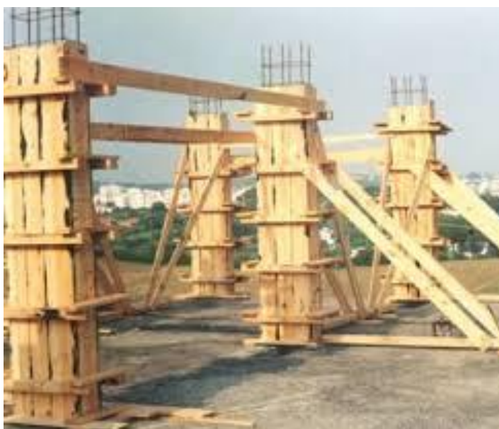
Figura 3.7 – Cofragem tradicional de pilares [16]
