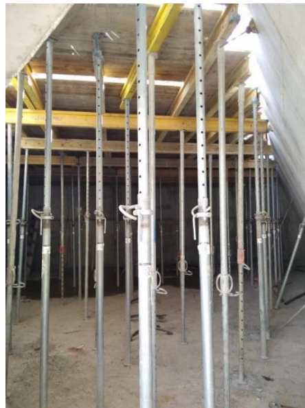
Figura 5.41 – Estrutura de suporte para a laje provisória
