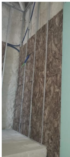
Figura 5.23 – Colocação da lã mineral
