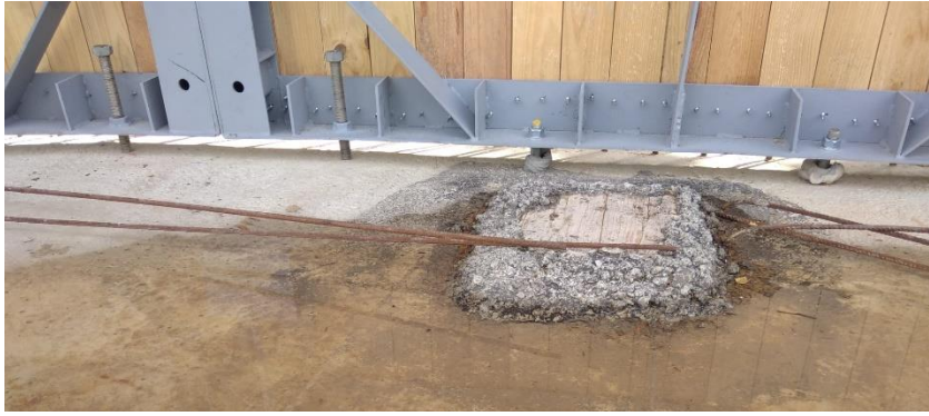
Figura 5.49 – Fixação dos painéis de cofragem
