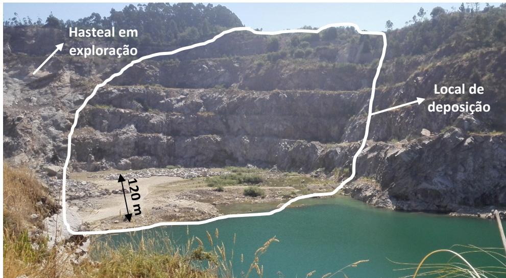
Figura 72-Local do aterro na pedreira “Vila Verde nº 2”
