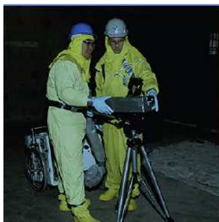
Figura 3.16: Demolição com o uso de laser [10]
