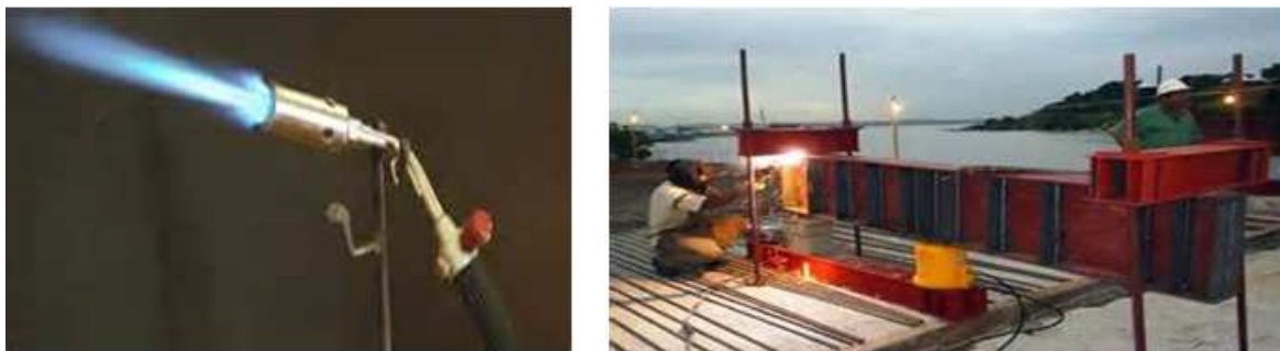
Figura 3.15: Demolição com uso de maçarico [49]
