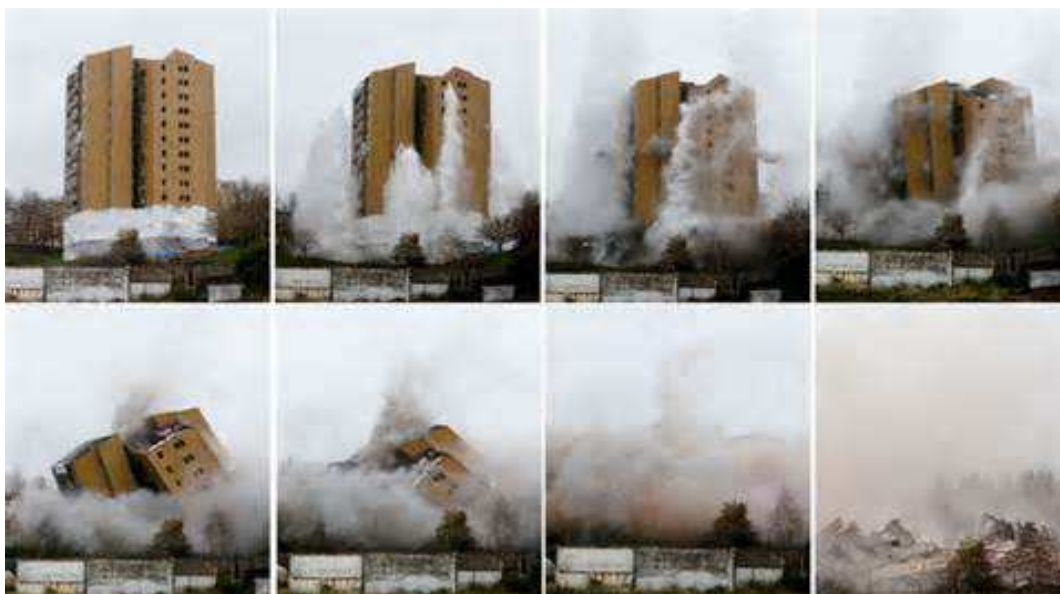
Figura 3.11: Demolição pelo método de implosão no Bairro do Aleixo [48]
