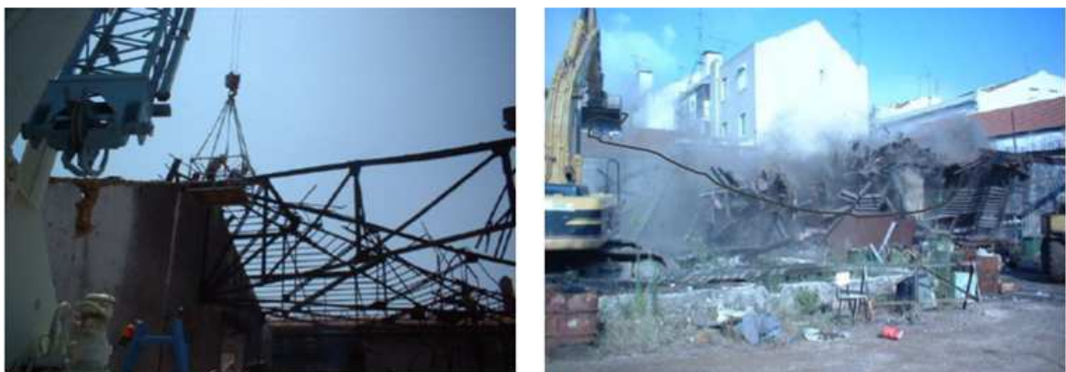
Figura 3.3: Demolição por tração após colocação de um cabo ligado à estrutura [11]
