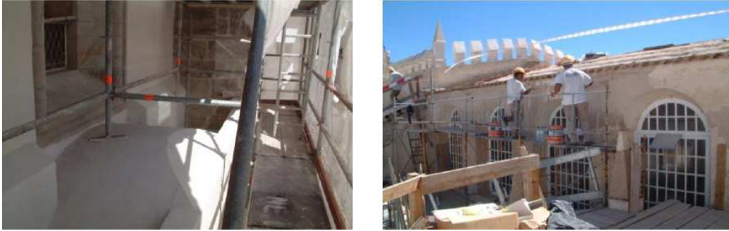
Figura 5.15: Exemplos de andaimes em obras [11]
