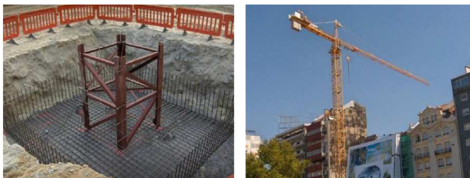
Figura 5.19: Colocação estratégica da grua [11]
