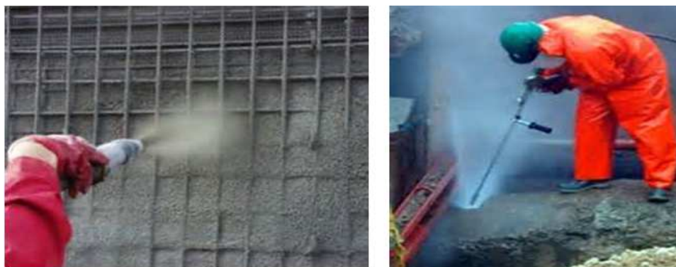
Figura 3.18: Demolição com o uso de jato de água [50]
