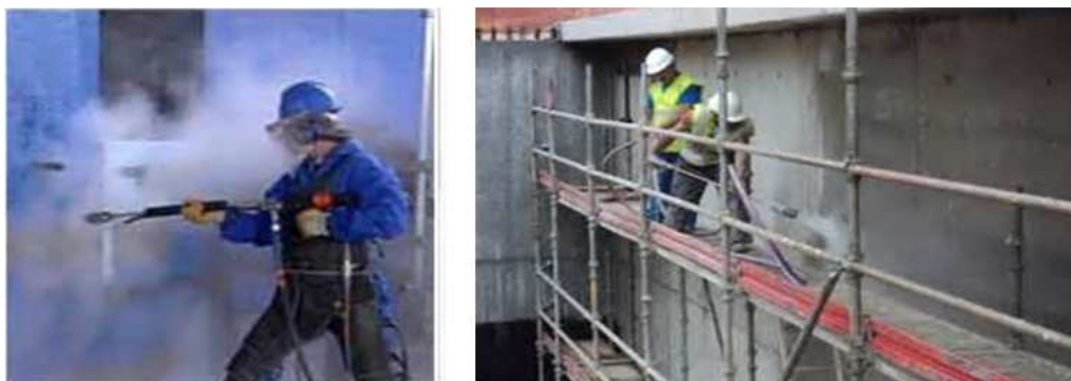
Figura 3.19: Demolição com uso de jato de água com areia [50]
