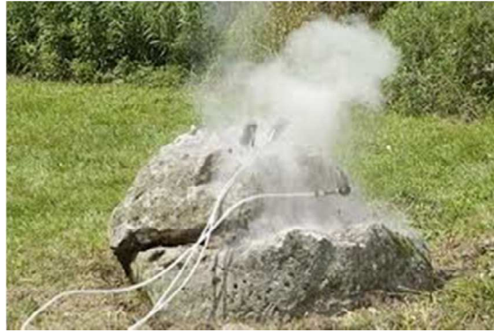
Figura 3.13: Demolição com o uso de explosivos pelo método de micro-explosão [21]
