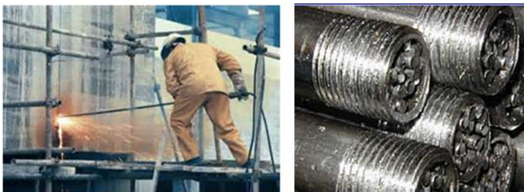
Figura 3.14: Demolição com o uso de lança térmica [49]
