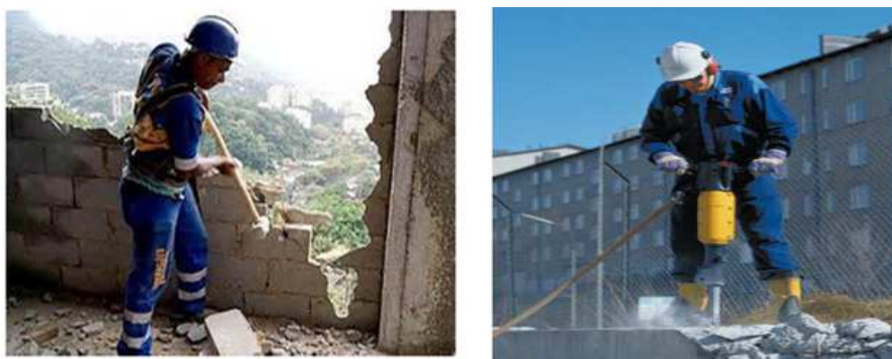
Figura 3.2: Demolição com ferramentas manuais, à esquerda a utilizar um martelo e à direita a utilizar um martelo pneumático [42]
