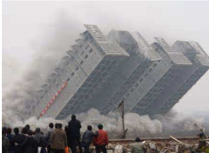
Figura 3.10: Demolição com uso de explosivos pelo método de derrube [47]
