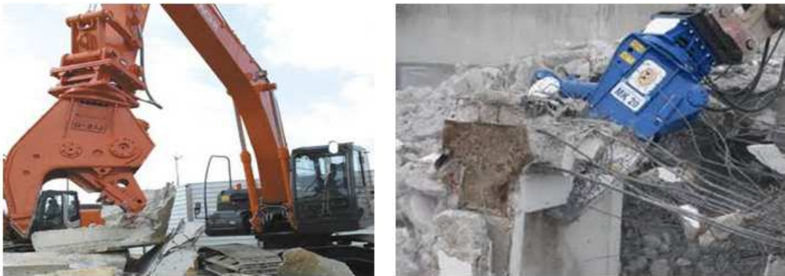
Figura 3.7: Demolição com a utilização de tesoura pulverizadora [46]
