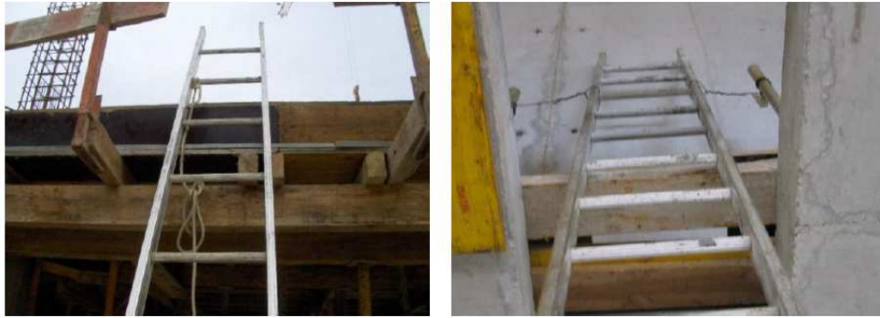
Figura 5.18: O mau posicionamento das escadas auxiliares, à esquerda a escada corre o risco de cair na vertical e à direita a escada encontra-se segura tanto na horizontal como na vertical [11]
