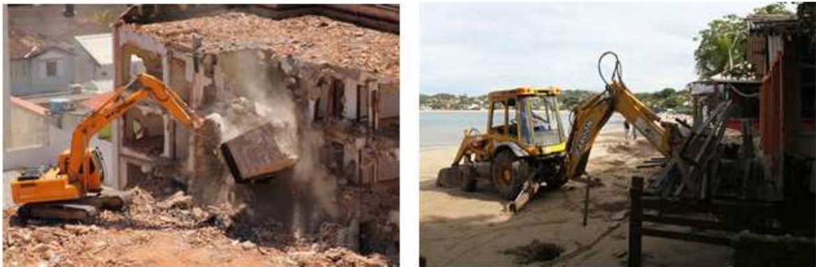
Figura 3.6: Demolição por impacto [44]
