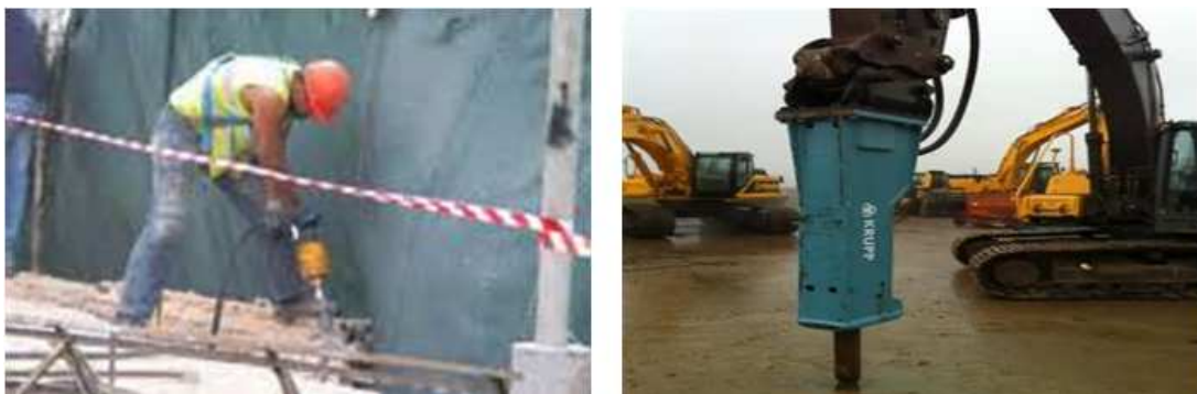
Figura 3.8: Demolição como o uso de martelo pneumático [44]
