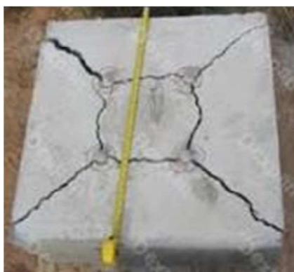
Figura 3.22: Demolição com uso de expansão química [27]
