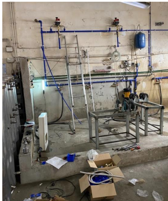
Figura 42 Montagem da solução em dois postos
