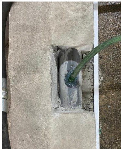
Figura 44 Conexão da mangueira de saída ao tubo de escoamento
