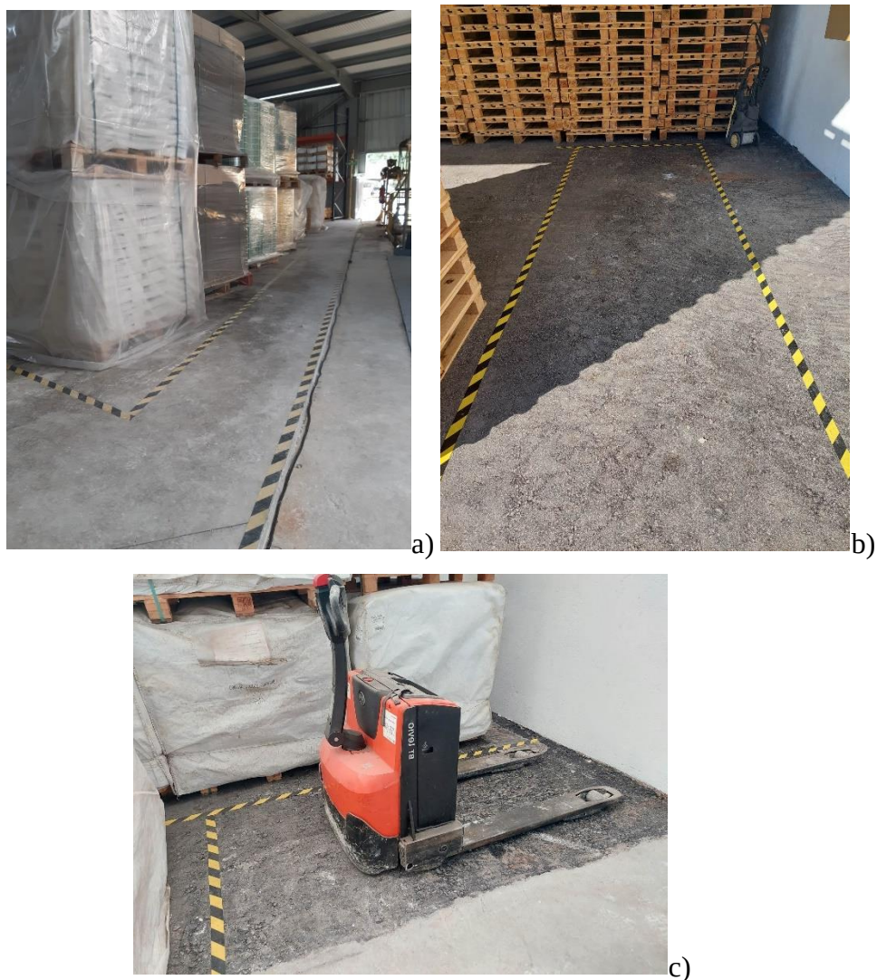
Figura 34- a) Corredor, b) Estacionamento do empilhador e c) Estacionamento do stacker.
