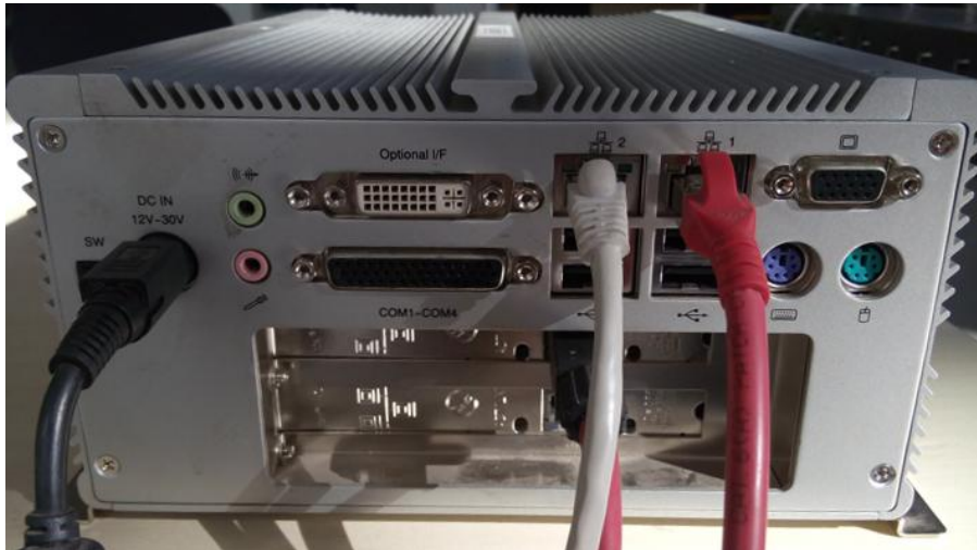
Figura 43 Controlador externo do sistema ótico de seguimento de junta
