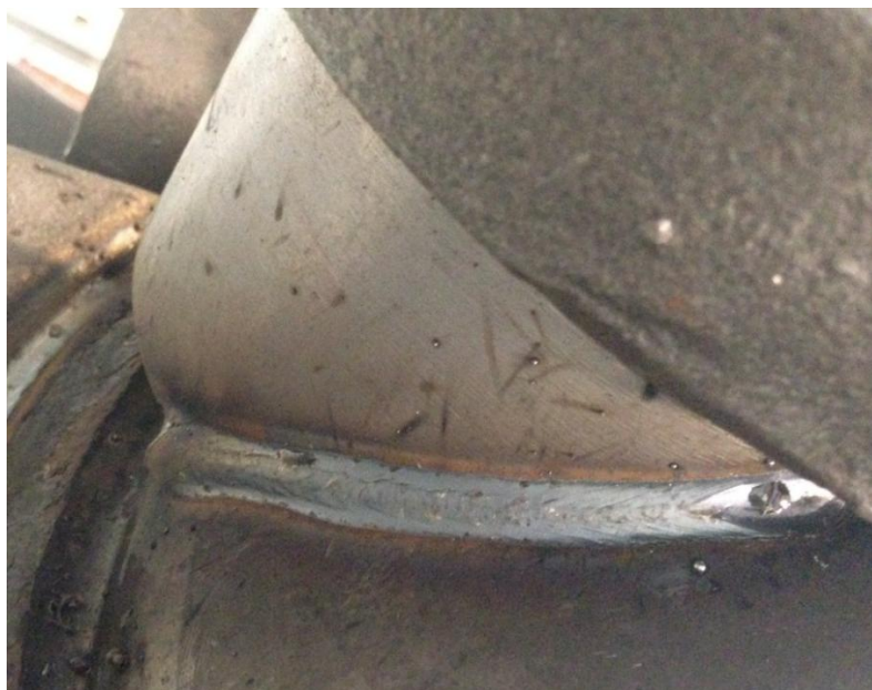
Figura 81 Aspeto visual do cordão de soldadura entre o eixo e a bucha
