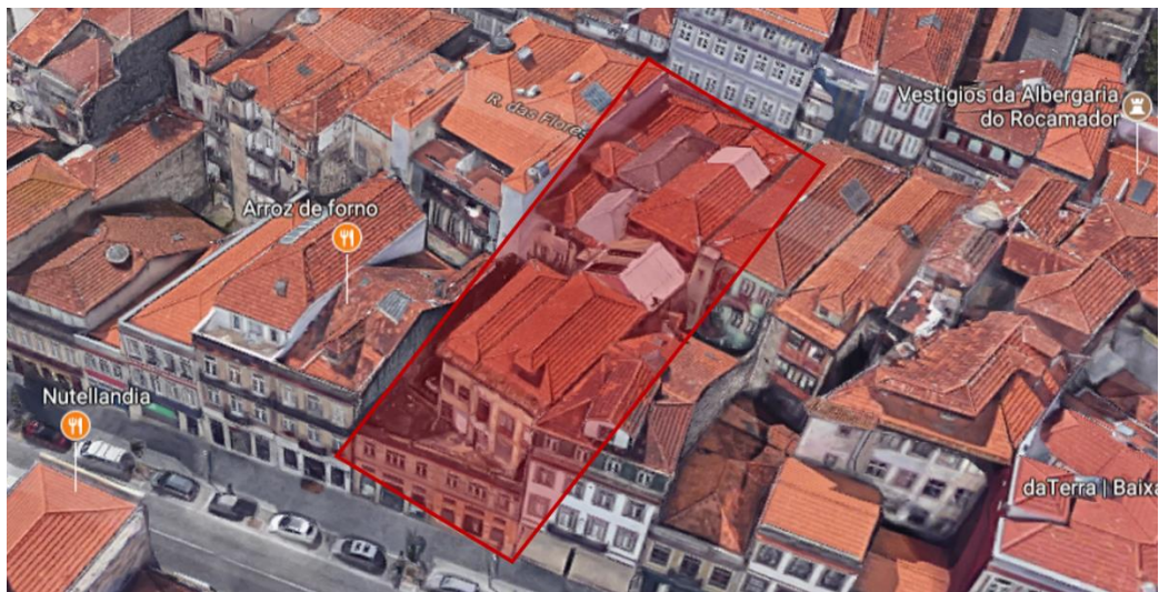
Figura 5.4 – Área de implantação do Edifício Flores Plaza
