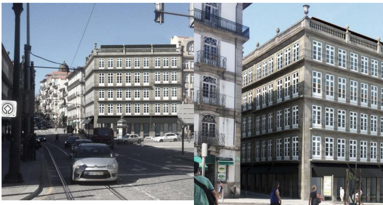
a) Vista Praça da Liberdade.
